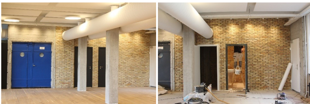
FIGUR 10: BILLEDER FRA DEN GAMLE TRIKOTAGEFABRIK PÅ ARTILLERIVEJ. DER ER OPSAT GAMLE MURSTEN VÆGSYSTEMER PÅ ENDEVÆGGEN
