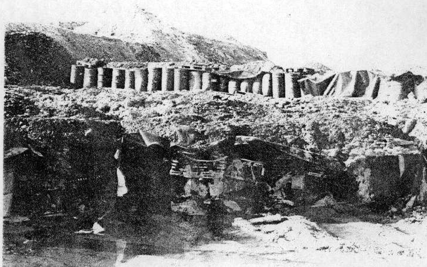
23. Andet affald aflæsses på et særligt afsnit af etape 2. Det meste affald er i jerntrømler og afdækkes straks. Billedet er taget nord fra mod fronten.
