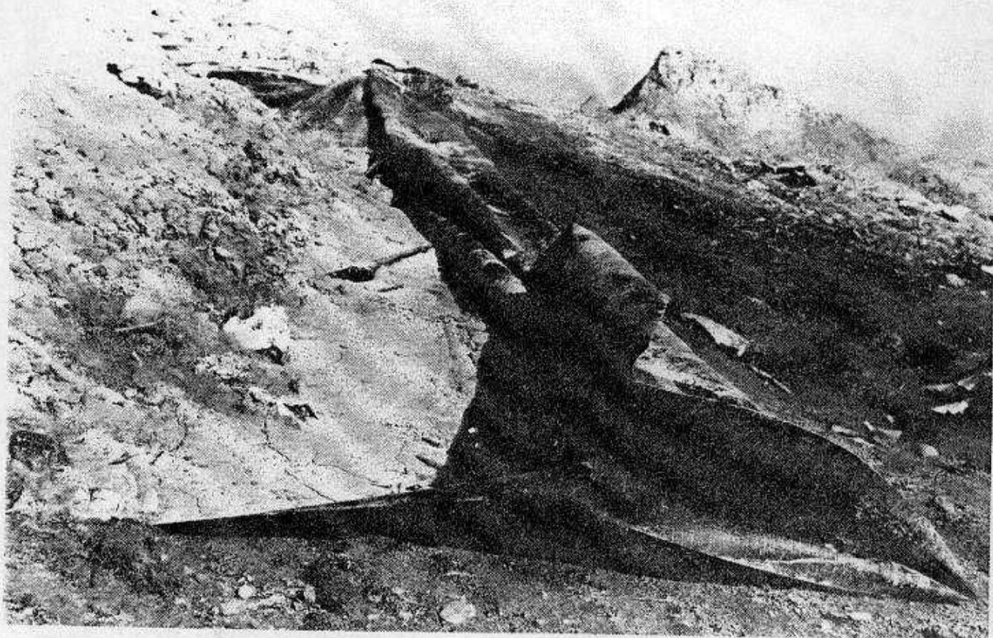
18. Filterkageafsnittene afdækkes med plastmembran og jordfyld samt muld. Her ses den anvendte polyethylenfolie "Polysheet" på etape 3.
