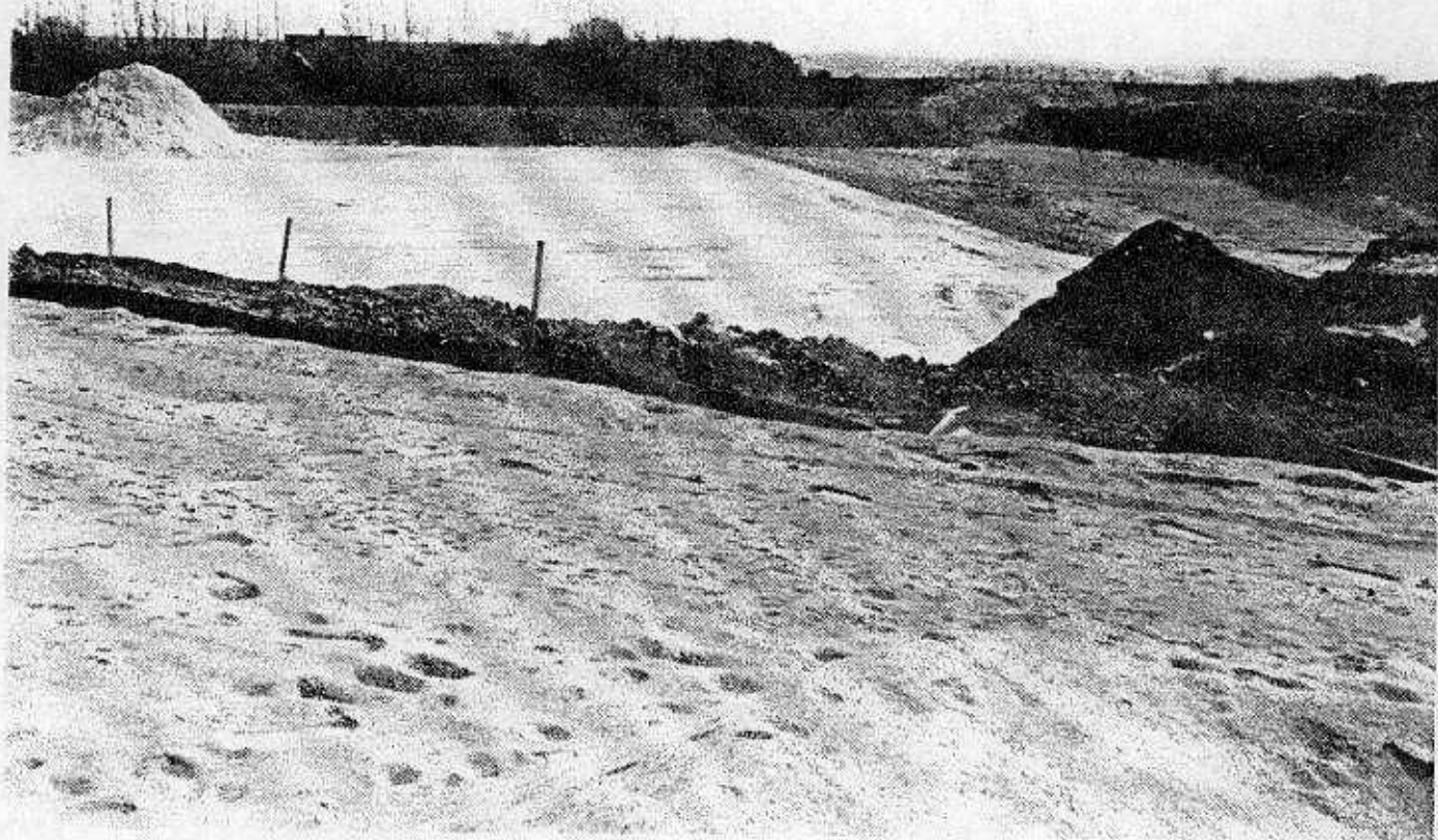
20. Etape 4 set mod øst. Slaggeafsnittet er endnu ikke taget i brug. I baggrunden ses Storebælt.
