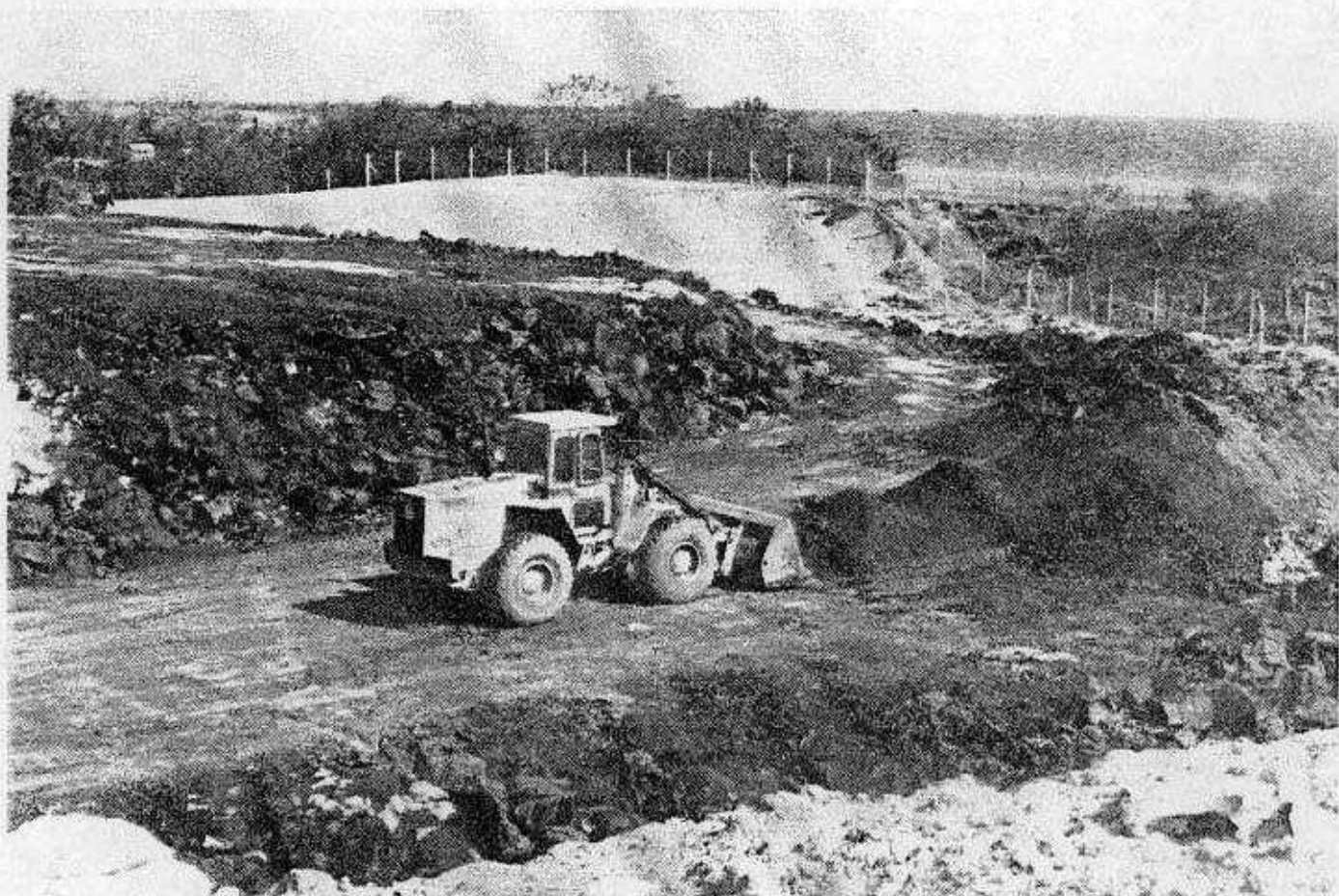
15. Slaggeafsnittet på etape 3 når i april 1987 helt ud til østgrænsen for deponeringen og tilføres her afdækningsjord.
