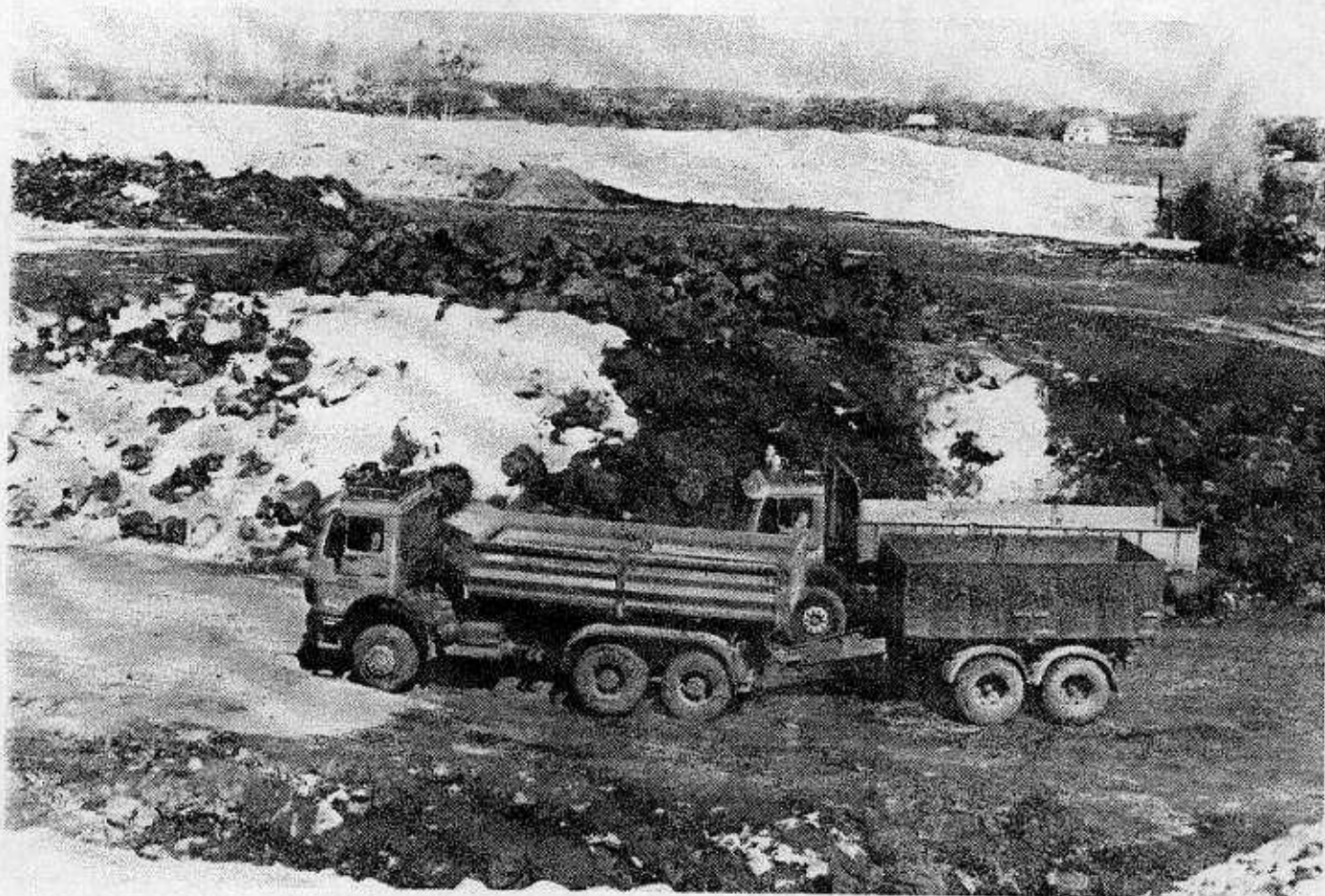
17. Lastbiler tilkører overskudsjord til slutafdækning, bl. a. på etape 3. I baggrunden ses etape 4 med nyudlagt kalk.
