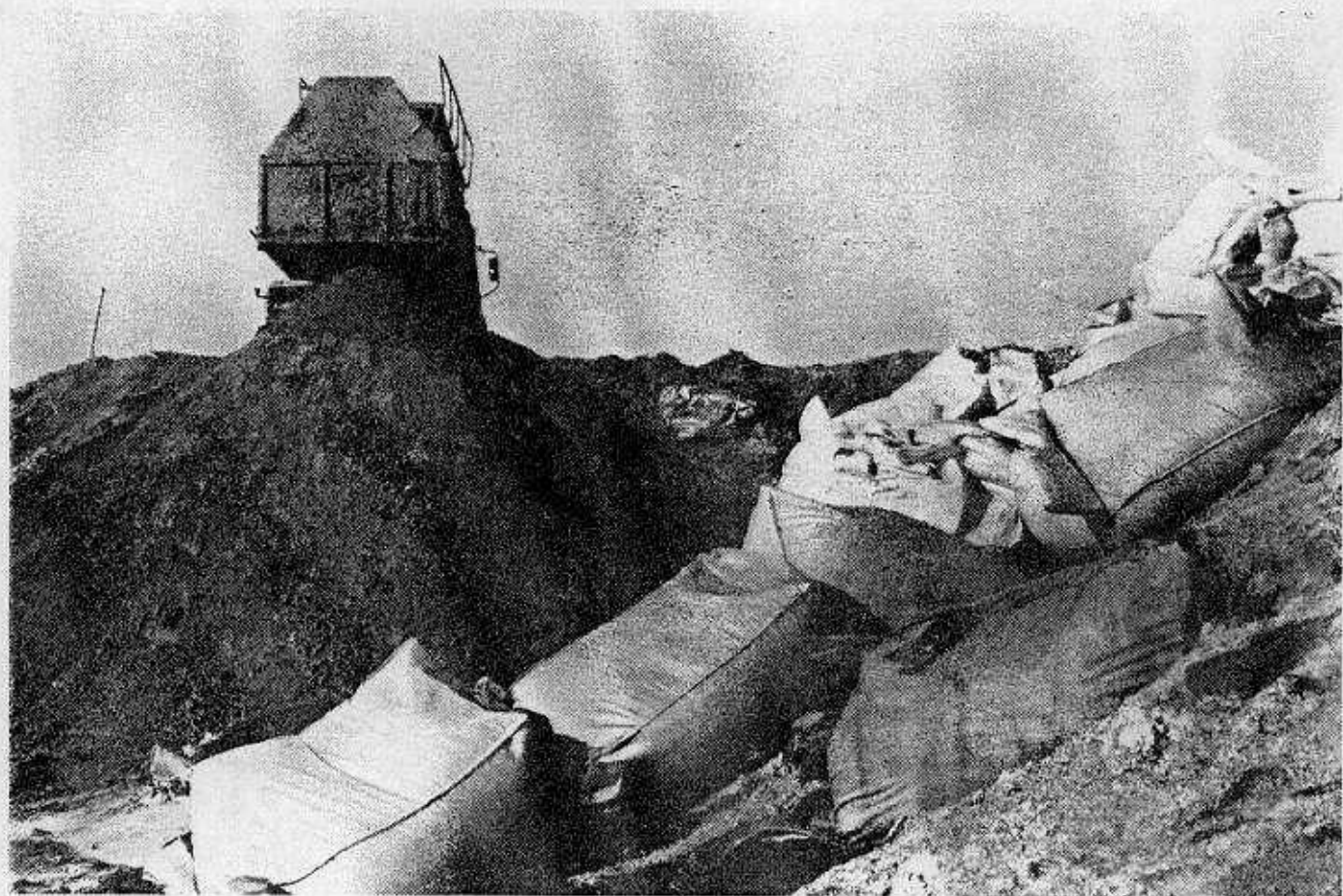
22. Tippefronten ved etape 4's filterkageafsnit. Containerlastbiler aflæsser befugtet flyveaske mellem filterkagerne. Sækkene indeholder forseglede filterkager.
