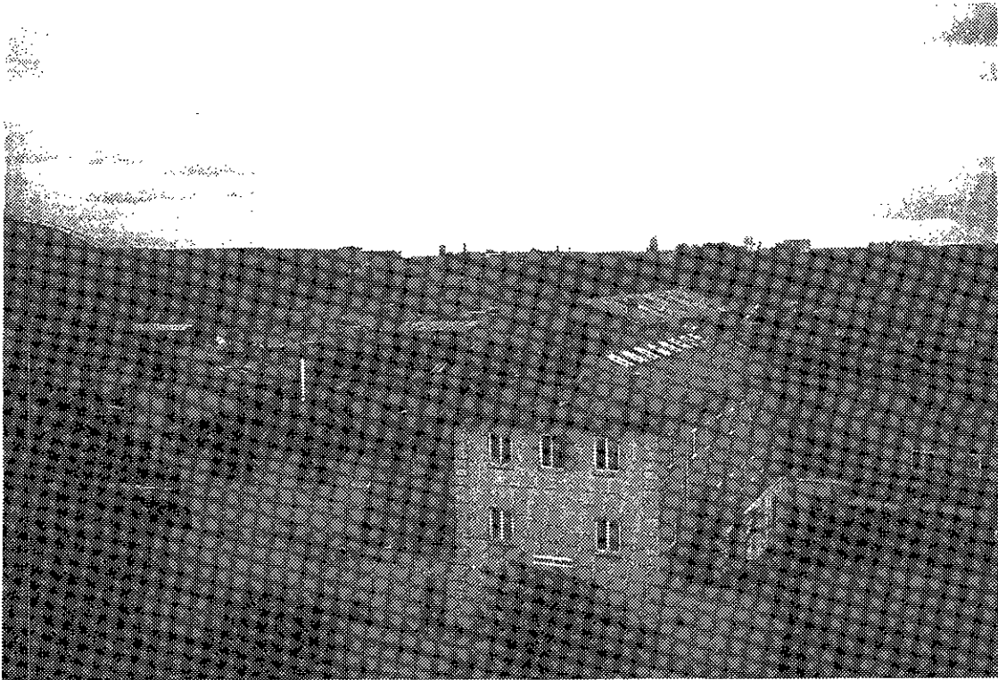
Foto 1. Kbh. Salatfabrik set fra sydøst før nedrivning
