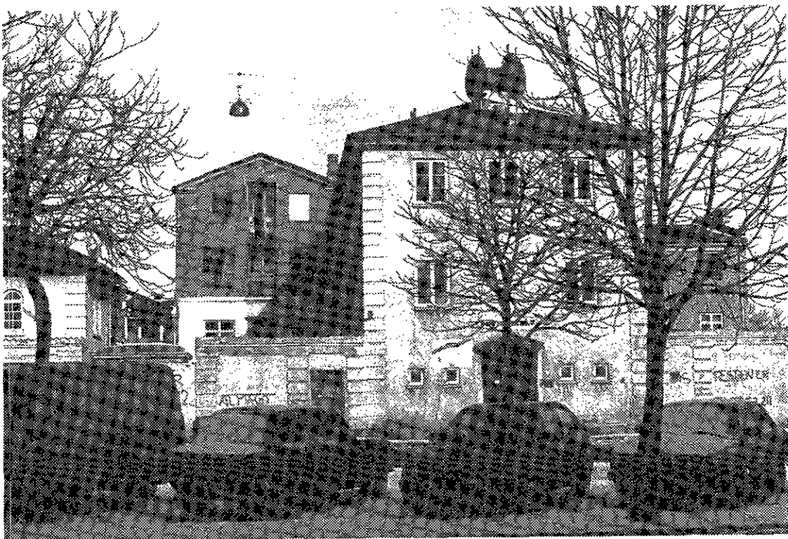
Foto 4. Fabrikken set fra sydøst før nedrivning
