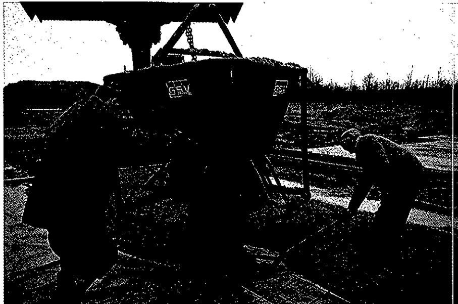
Figur 4.14 Udstøbning af gulvpladerne i Bellinge
