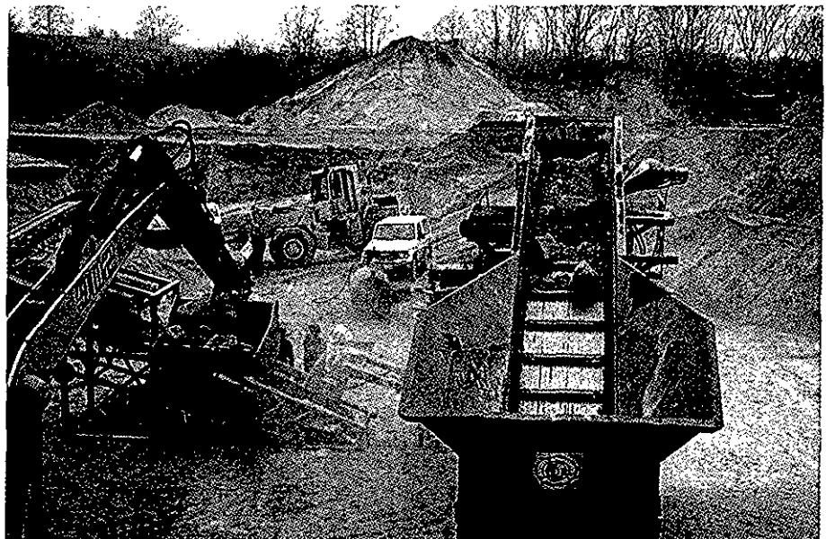
Figur 4.5 Knusning af betonbrokker på et mobilt anlæg
