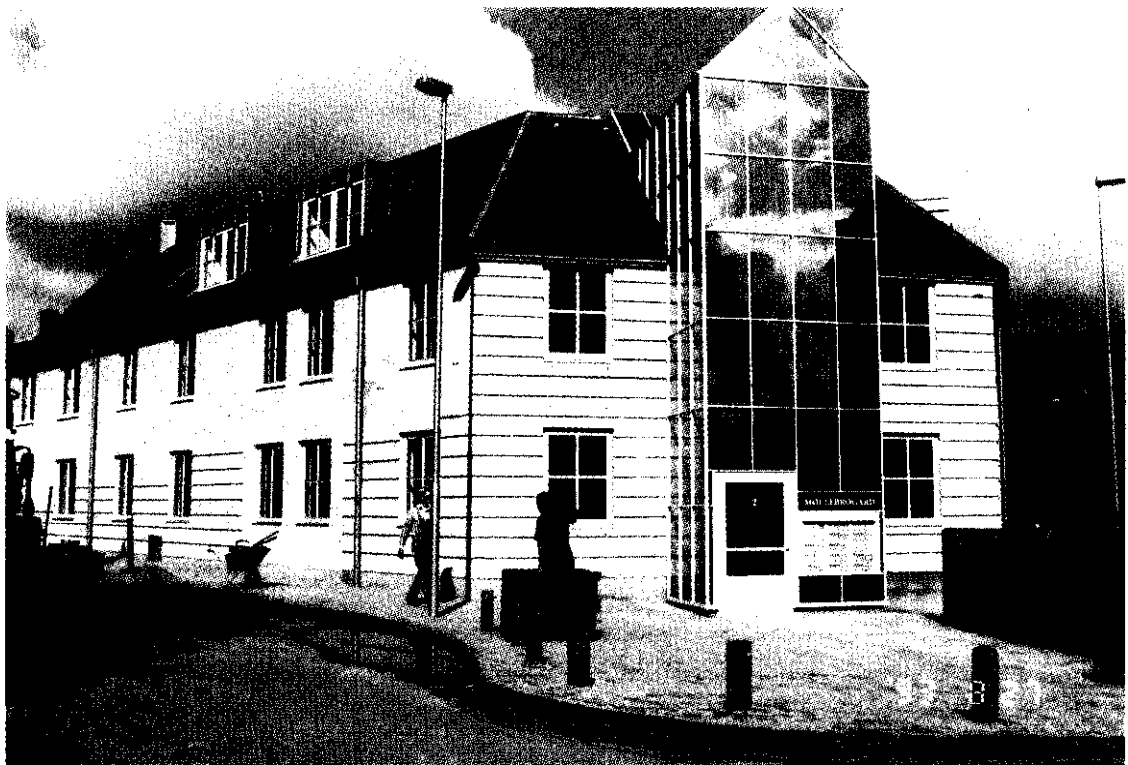
Figur 10. Genbrugshuset i Odense. Tagbeklædningen er udført med genanvendte skiferplader
