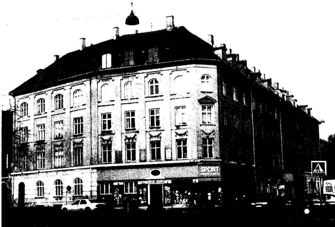
Figur 1 Typisk Københavnsk ejendom fra sidst i forrige århundrede med tagkonstruktion udført som saddeltag med tagtegl.
