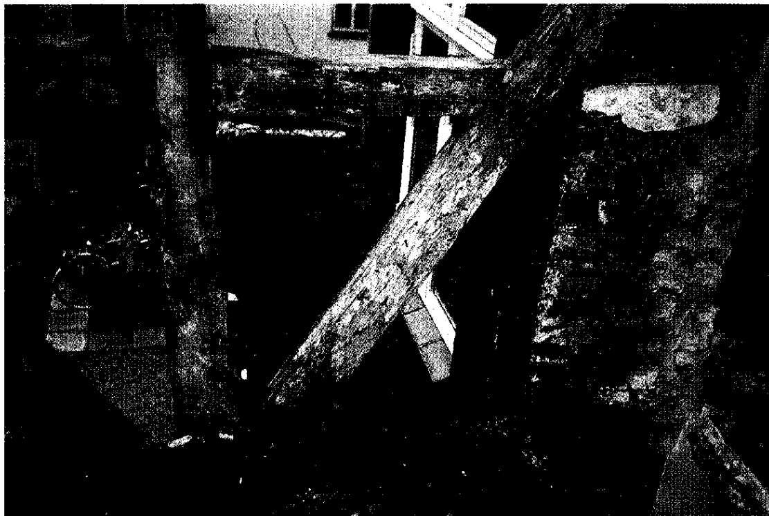
Billede 9. Bindingsværk i baghus, væg nærmest nr. 11 - 2. sal.
