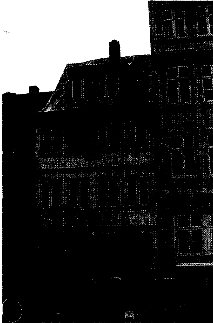
Fig. 15. Olfert Fishersgade 9 ved start af reovering.
