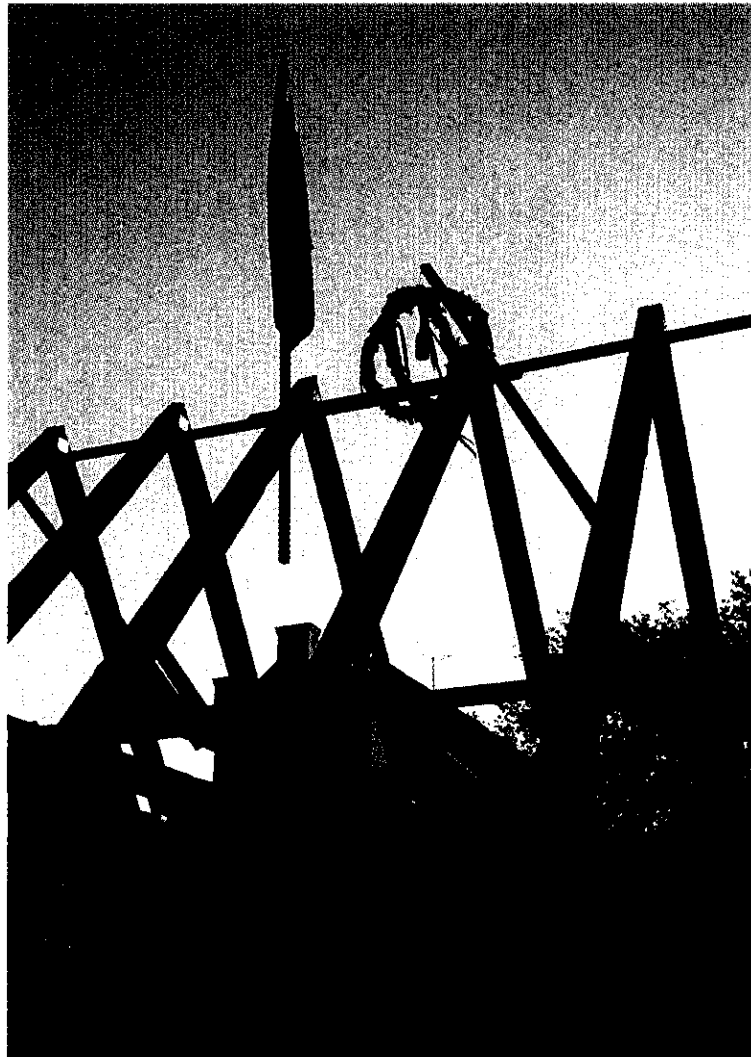
Fig. 18. Rejsegilde på Olfert Fischersgade 9, bemærk hanebånd af genbrugstømmer.
