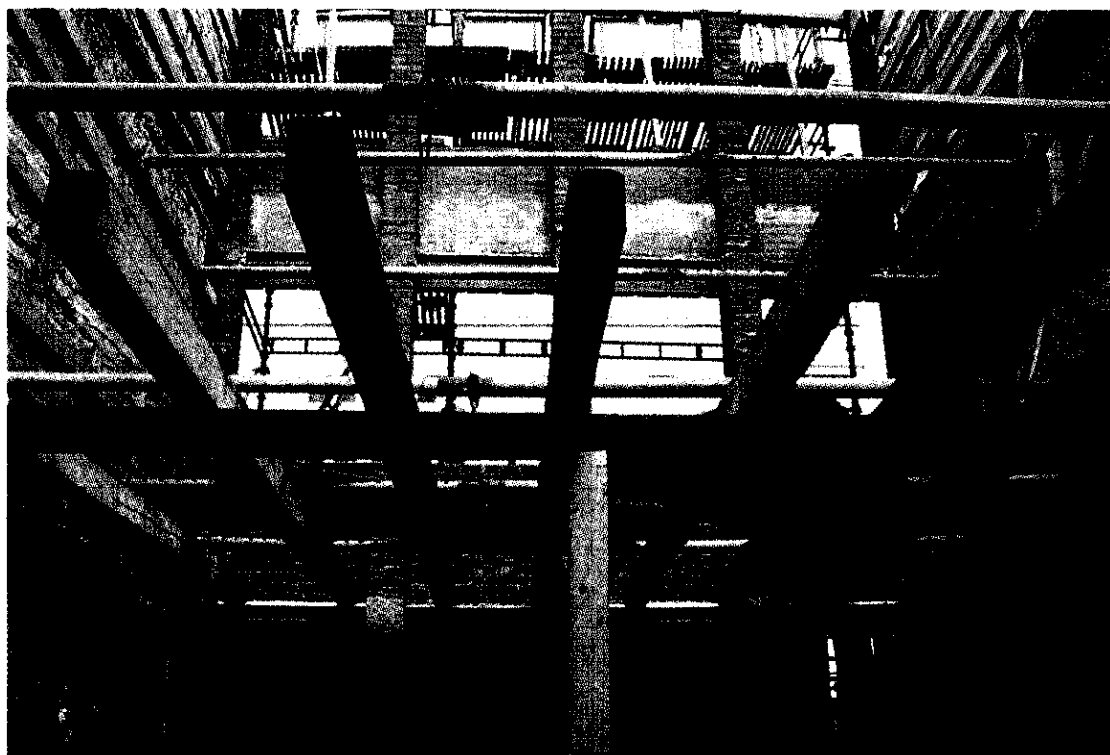
Fig. 17. Bjælkelag af genbrugstømmer.
