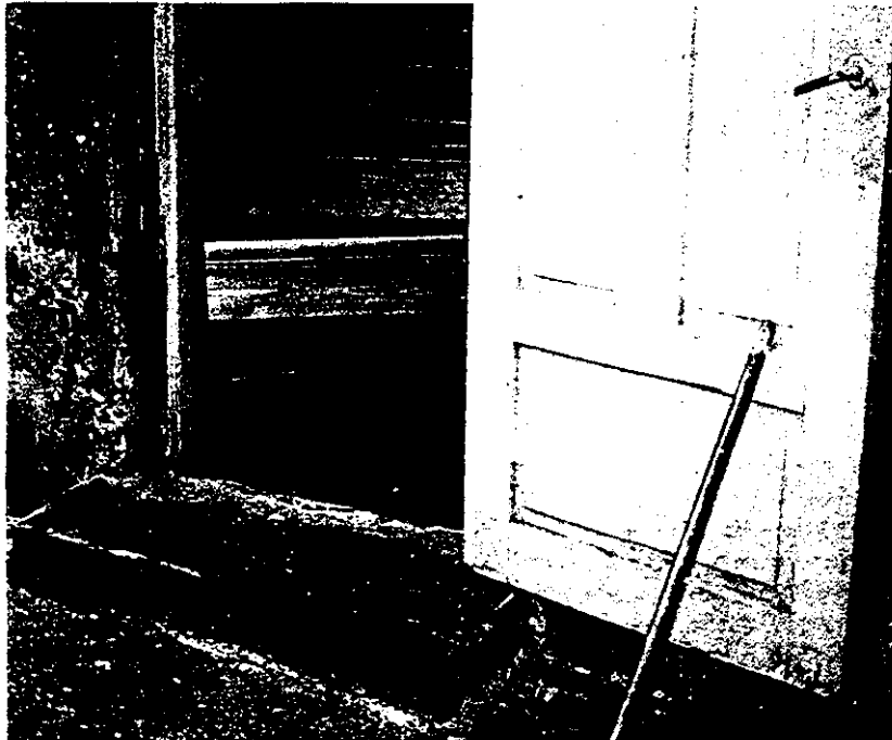
Fig. 1. Trappe mangelfuldt repareret efter svampeskade forårsaget af Ægte Hussvamp.
