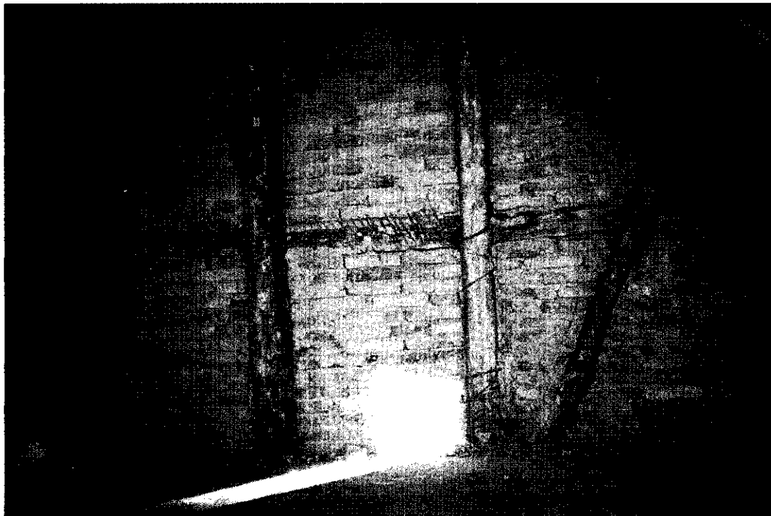
Billede 13. Bindingsværk i forhus, gavl mod nr. 11 - spidsloft.
