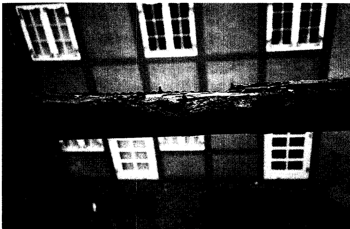
Billede 8. Bindingsværk i baghus, løsholt mod gård - 2. sal.
