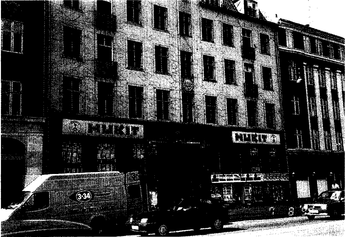
Fig. 9. Foto visende Nørrebrogade 3 med hul i facaden til placering af container til opsamling af nedrivningsprodukter.
