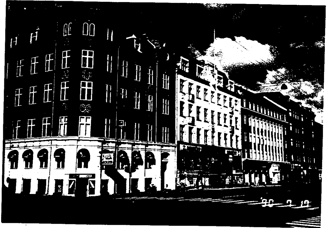
Fig. 7. Foto af Nørrebrogade 3 før nedrivning
