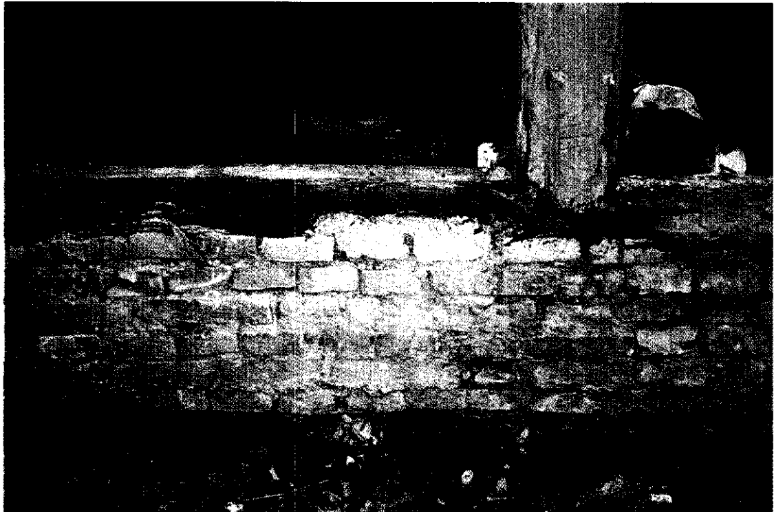
Billede 4. Bindingsværk i baghus, væg mod baggård - stueetage.
