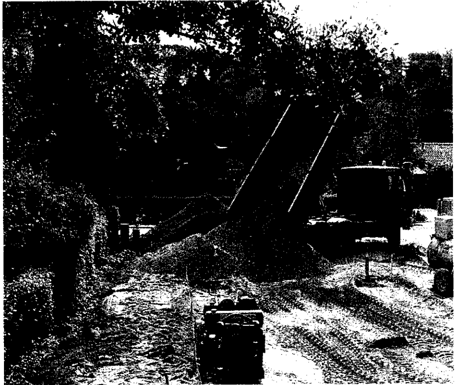
Foto 1 Aflæsning af knust beton på byggepladsen
