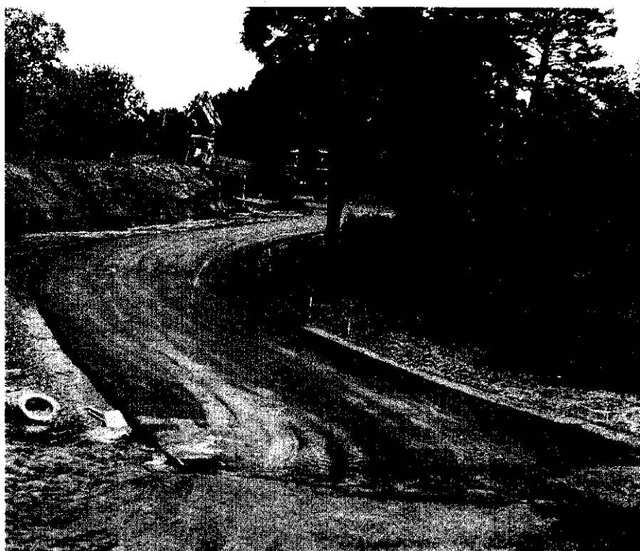
Foto 8: Asfaltbærelag er udlagt
