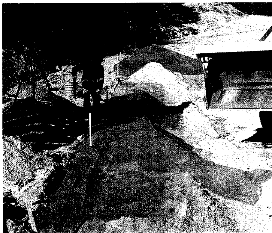
Foto 5 Udlægning af knust tegl som underlag for fortovsfliser
