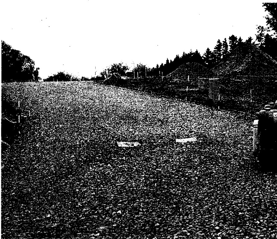
Foto 4 Komprimeret beton-makadam
