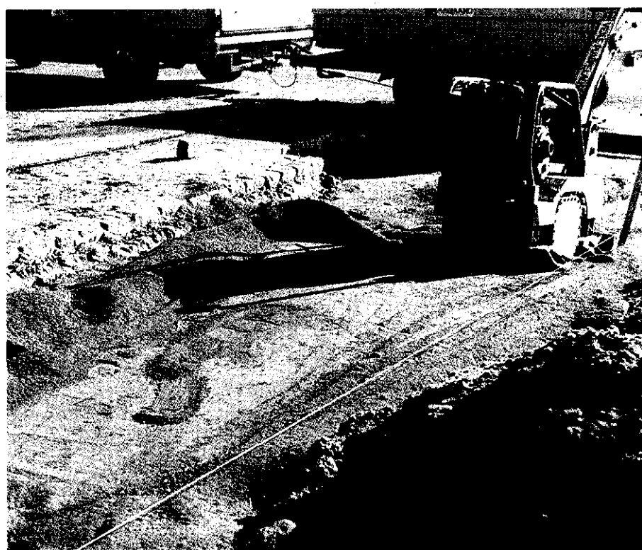
Foto 6 Komprimering af knust tegl
