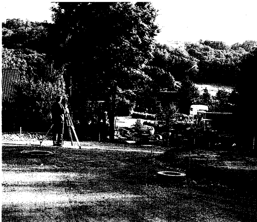
Foto.7 Måling/nivellement af overflade - med totalstation
