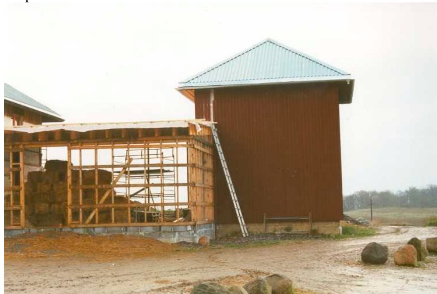
Figur 4. Prøvehus II i Hjortshøj under konstruktion.
