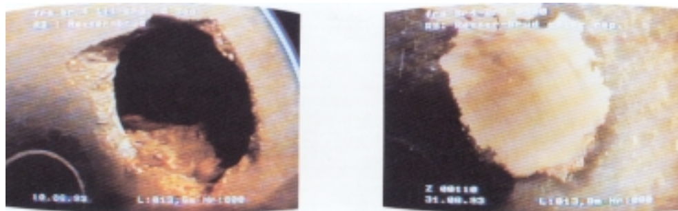
FIGUR 8.4 Afpropning ved hjælp af Amcrete.
