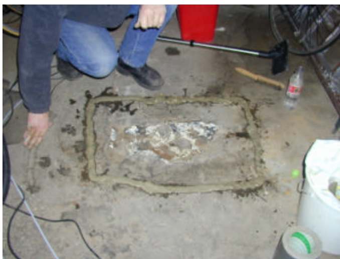
Figur 3. Klargøring til foliepålægning omkring et potentielt særligt forurenende område, punkt F-HS2: Beskadiget område i betongulvet.
