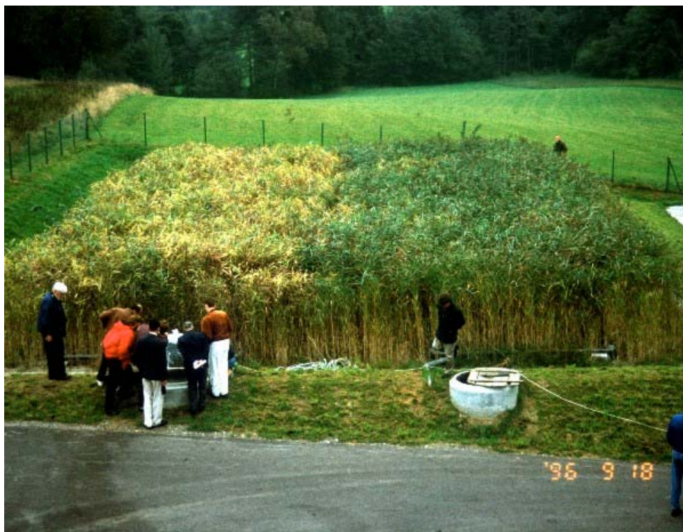
Beplantet filteranlæg med vertikalt flow i Østergård. Anlægget er beplantet med Tagrør og er inddelt i to parallelle bede. Planternes forskellige farve skyldes at de to bede har været belastet forskelligt (Foto: H. Brix)
