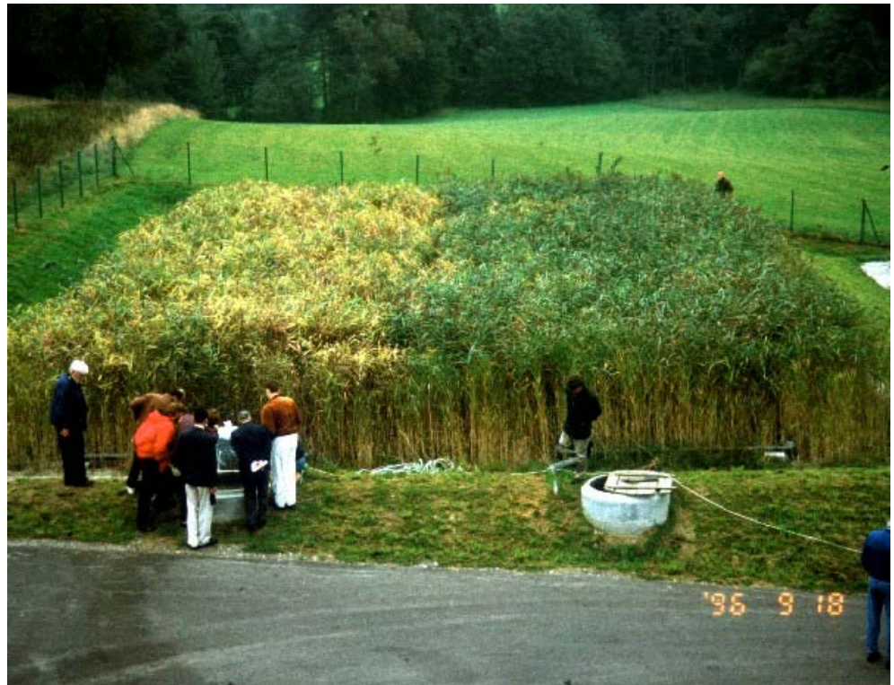
Figur 2-4 Beplyntet filteranlæg med vertikalt flow i Østvig. Anlægget er inddelt i to parallelle bede (Foto: H. Brix)
