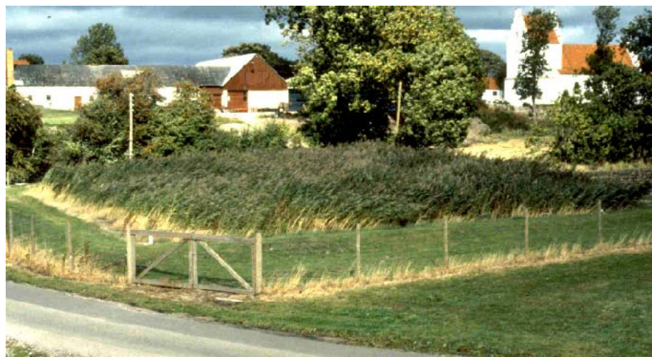
Figur 2-2 Typisk dansk rodzoneanlæg anlagt til behandling af husspildevand (Foto: H. Brix)
