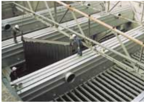
Elektrofiltre udskiftes i Dolna Odra, Polen, kraftværket for at reducere udsendelsen af flyveaske.
