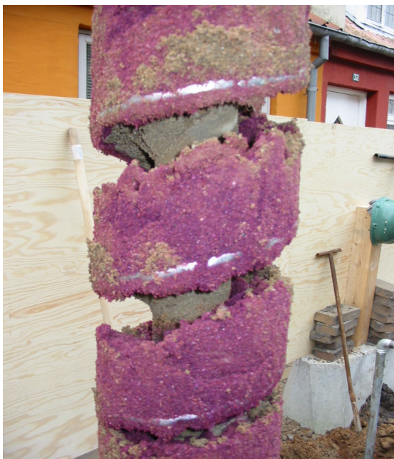
Rødfarvning af jorden ved injektion af kaliumpermanganat.
