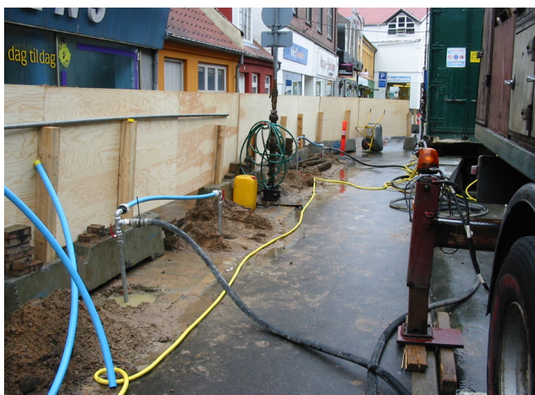
Injektion med lansemetode. Der ses 4 injektionspunkter. Det fremgår at arbejdsplads er afspærret i forhold til fortov
