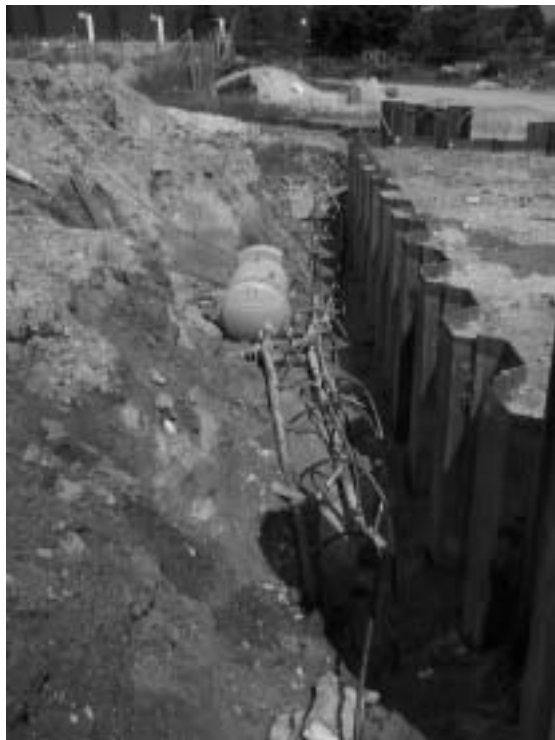
Grundvandssænkning med sugespidser.
