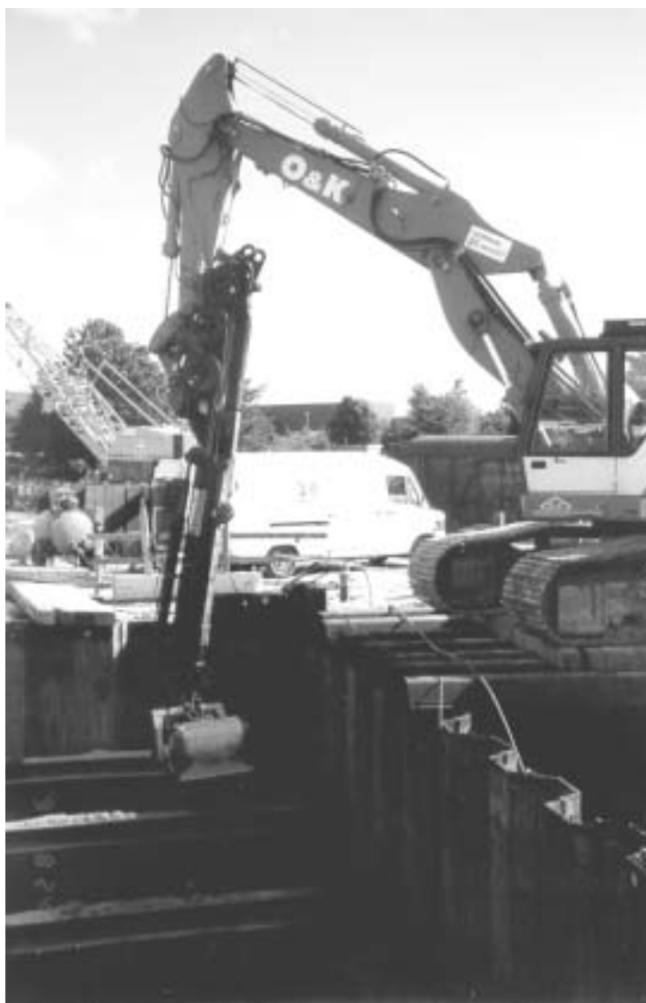
Udgravning under vand
