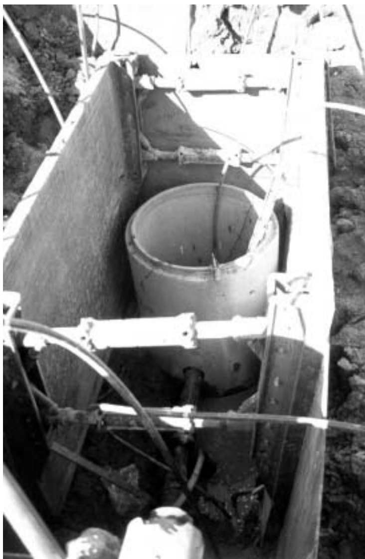
Etablering af drænbrønd i gravekasse og med grundvandssenkning.
