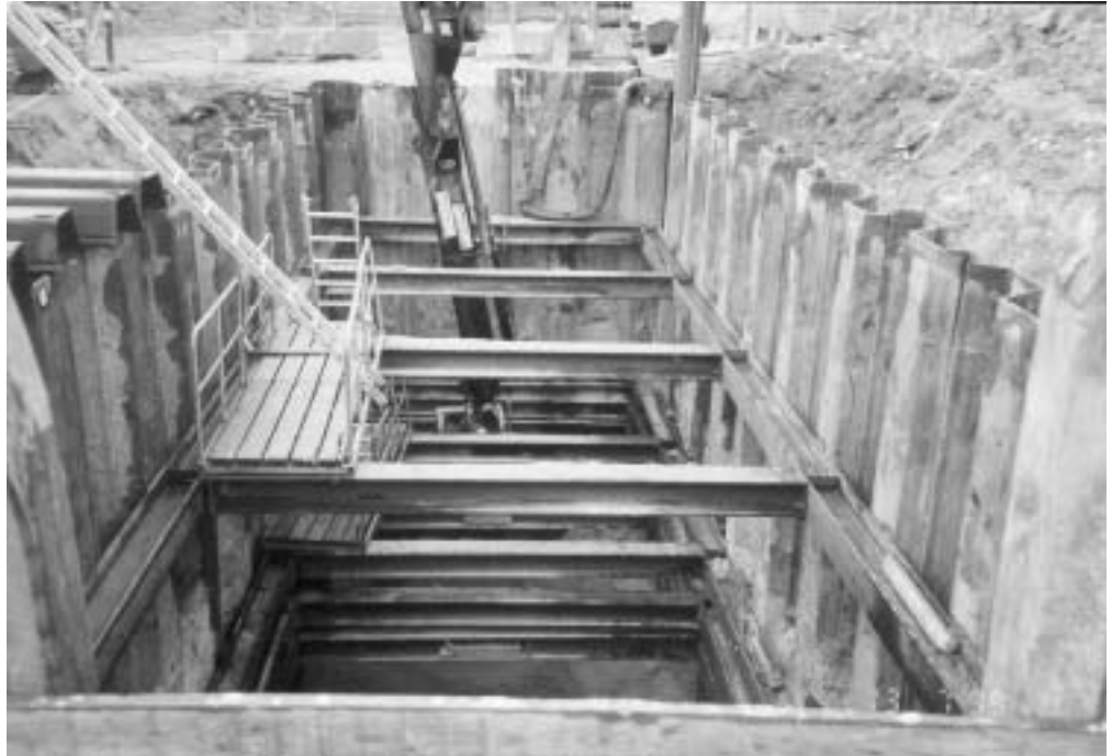
Udgravning i spunskasse med afstivninger
