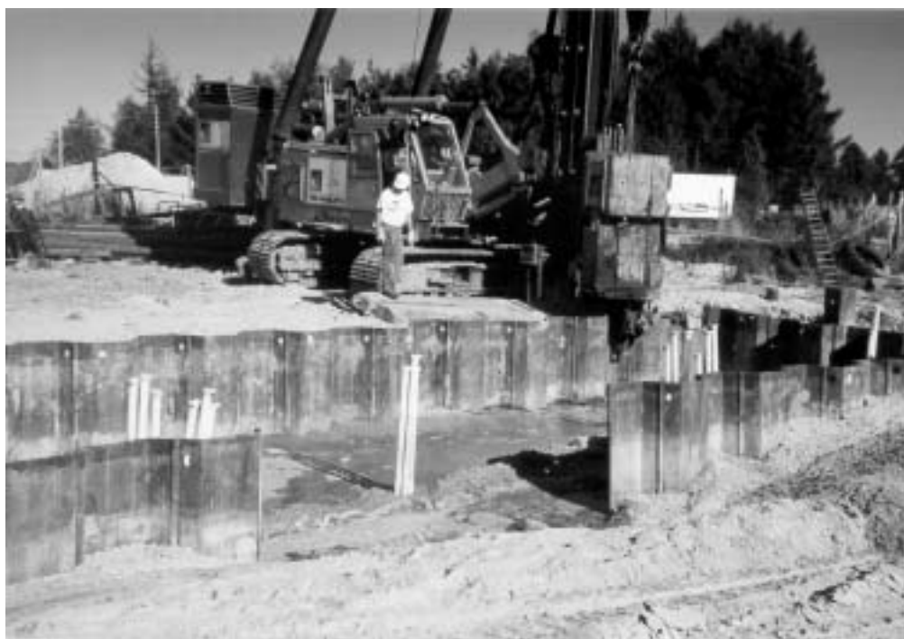
Optrækning af spuns ved vibration
