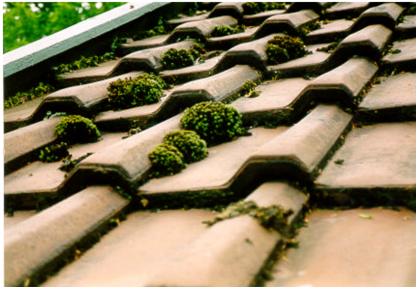
Figur 10.1: Tegl tag K21 tagsten - med mosvækst i overlap
