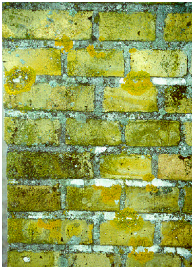
Figur 10.9: Gult teglstensmurværk med lavvækst i fuger der spreder sig ud over murstenene.
