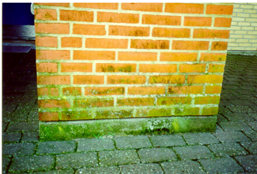
Figur 10.3: Øget algevækst nederst på en fritstående teglstensmur sandsynligvis forårsaget af en kombination af opstigende grundfugt og opsprøjt.
