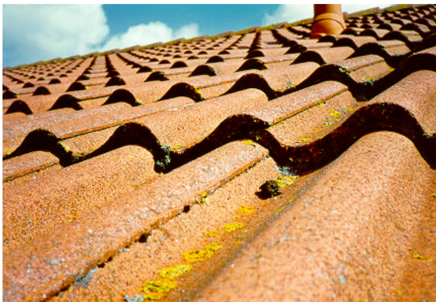
Figur 9.2: Betontagsten bevokset med forskellige arter af lav
