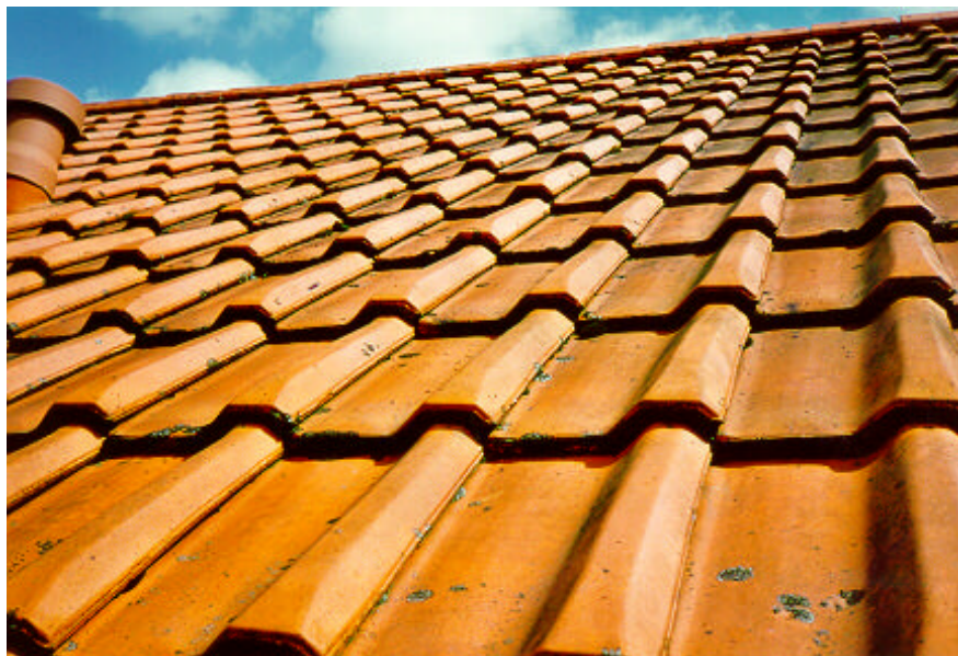
Figur 9.5: Rødt tegl tag med enkelte plamager med lavvækst.
