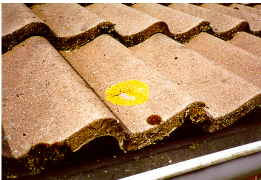
Figur 9.3: Brun betontasten med lavvækst på overfladesiden og mospuder på endefladerne
