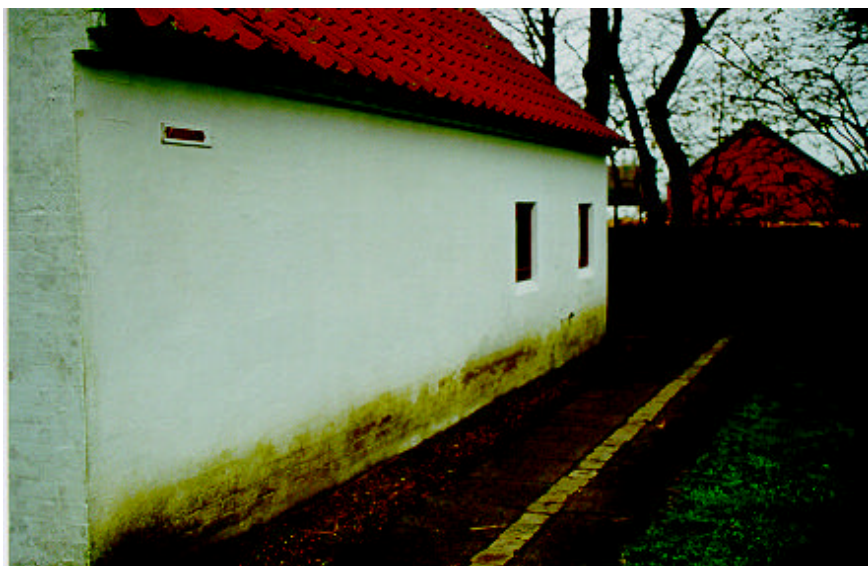
Figur 10.2: Øget algevækst på kal ket kirke forårsaget af opstigende grundfugt.
