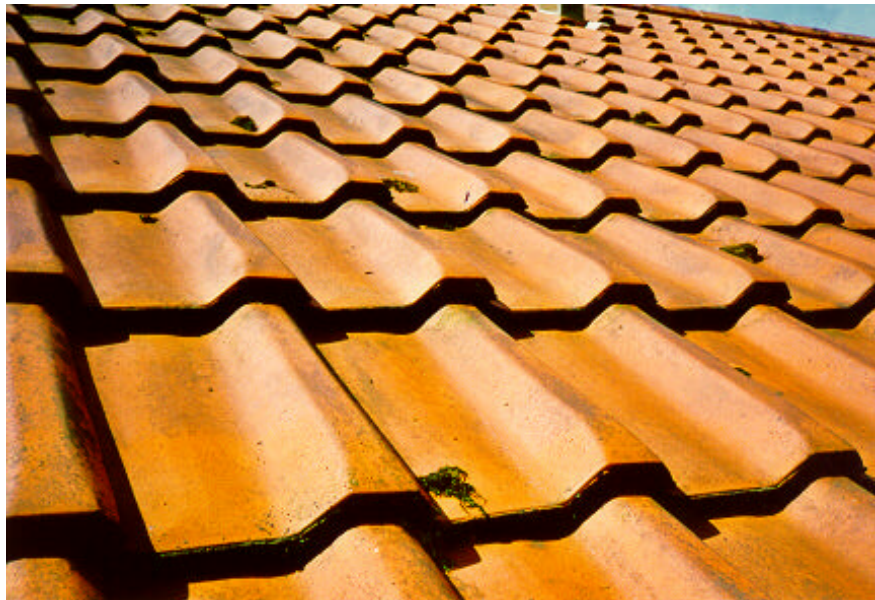
Figur 9.4: Rødt tegl tag med enkelte mospuder der hæfter i overlap mellem tagsten og svag algevækst
