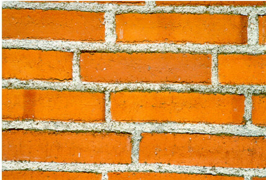
Figur 9.7: Mosvækst i fuger
