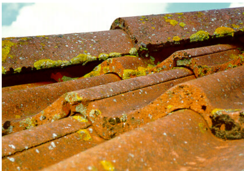
Figur 9.10: Vækst på rygningsten, betontag
