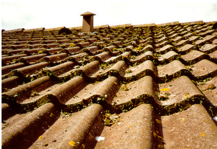
Figur 9.11: Betontag med kraftig vækst
