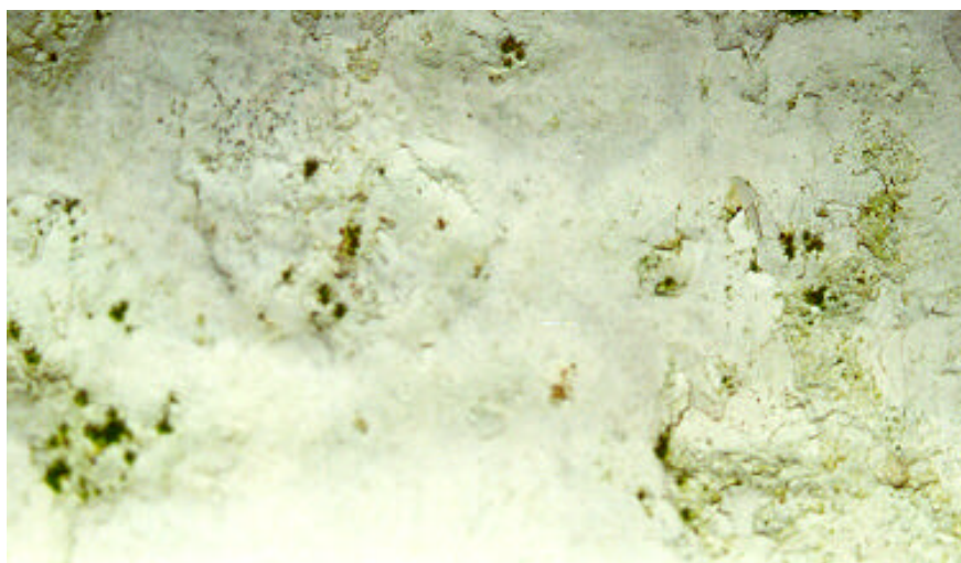
Figur 12.2: Kalket murværk med algevækst bag yderste kalklag.
