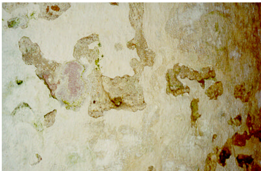
Figur 12.1: Pudset , kalket murværk med afskalninger
