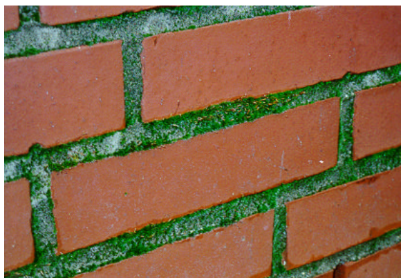
Figur 7.5: Murværk med mosvækst i fuger.
