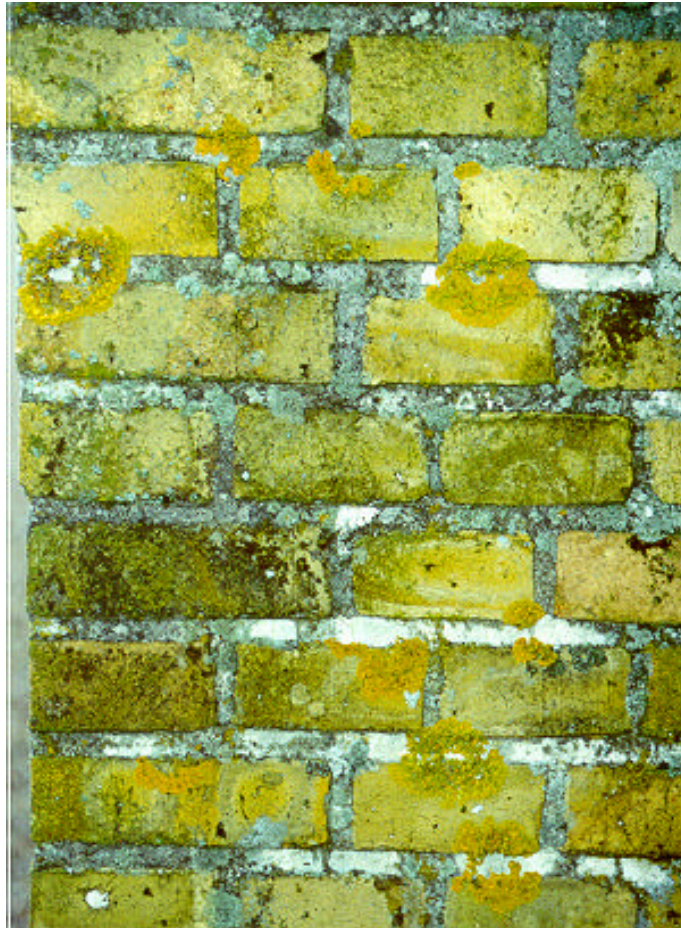
Figur 11.9: Gul t teglstensmurværk med lavvækst i fuger der spreder sig ud over murstenene.
