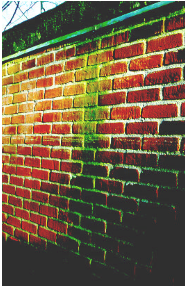
Figur 11.4: Vækst forårsaget af utæt løskant
