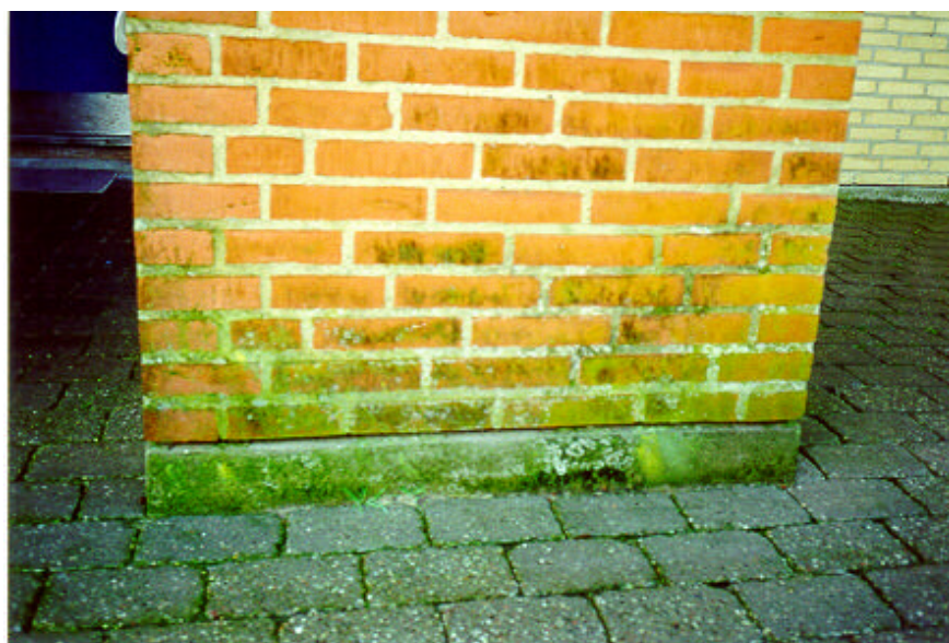
Figur 11.3: Øget algevækst nederst på en fritstående teglstensmur sandsynligvis forårsaget af en kombination af opstigende grundfugt og opsprøjt.
