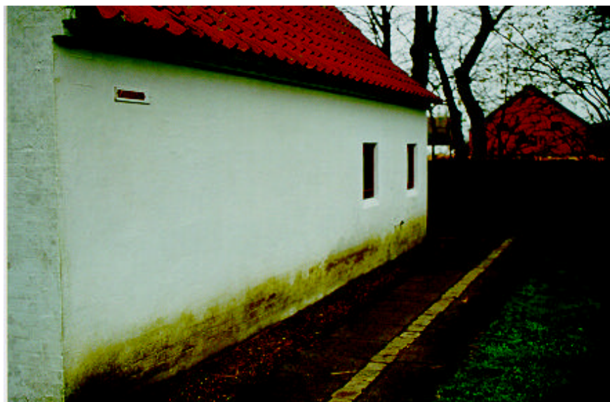
Figur 11.2: Øget algevækst på kalket kirke forårsaget af opstigende grundfugt.
