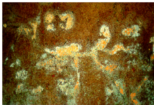
Figur 7.3: Pudset og malet facademurværk med svampevekst
