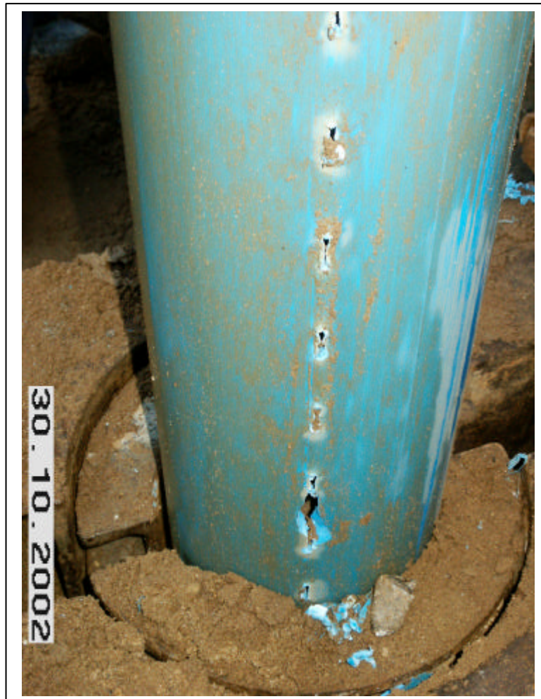
Figur 5.2.2.1 Billede af et perforeret forerør.
