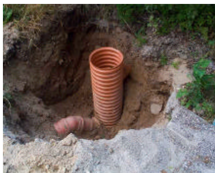
Figur 2.2: Eksisterende sandfang, Vestbadet 1999
