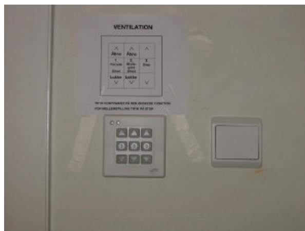
Figur 1. Betjening af naturlig ventilation sker manuelt af brugerne.
