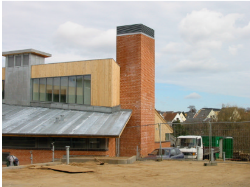
Figur 2. Luften trækkes ind via den murede skorsten
