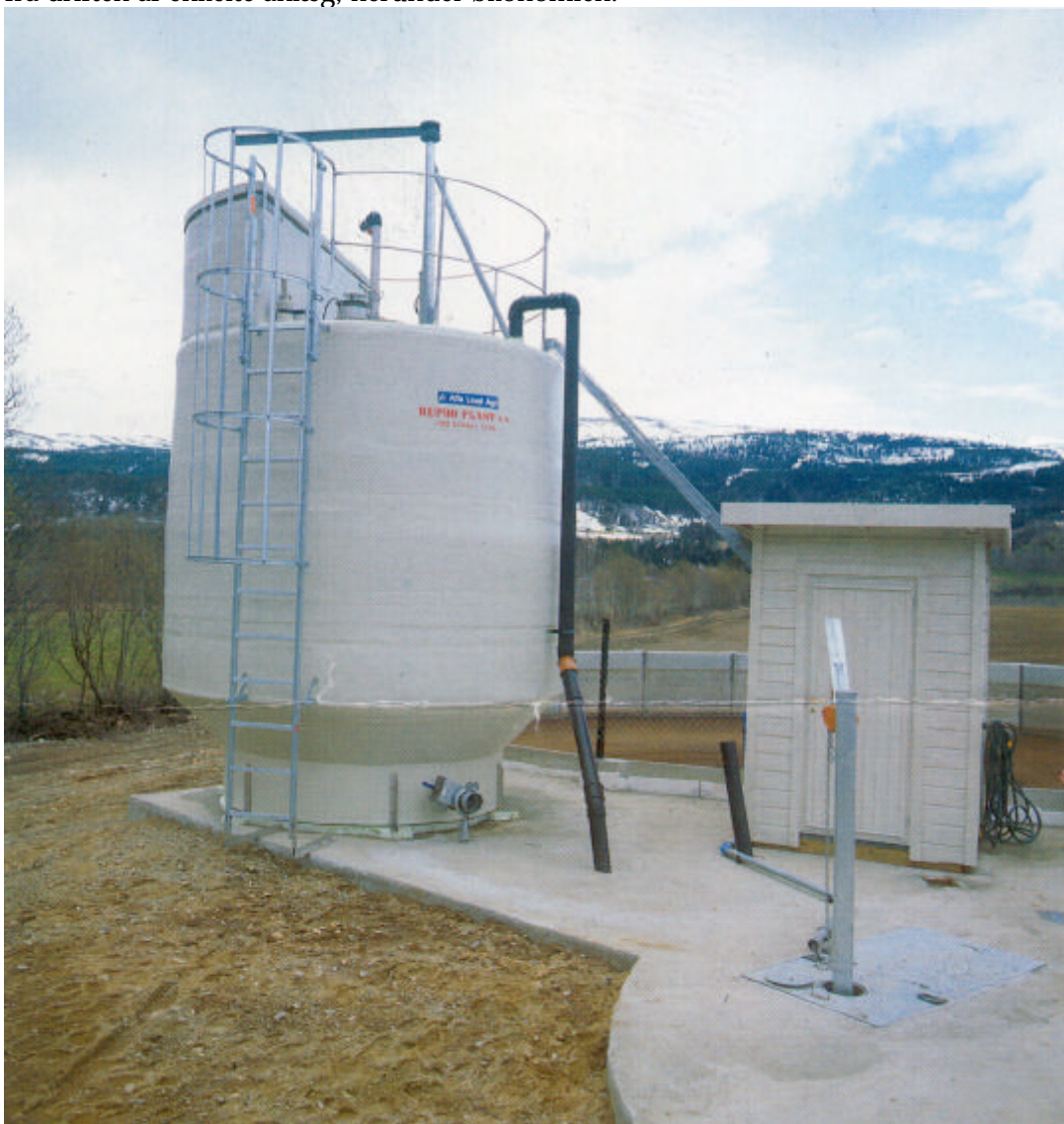
Figur 10.1 Vådkomposteringsreaktor. Kilde: Alfa Laval Agri (brochure).
