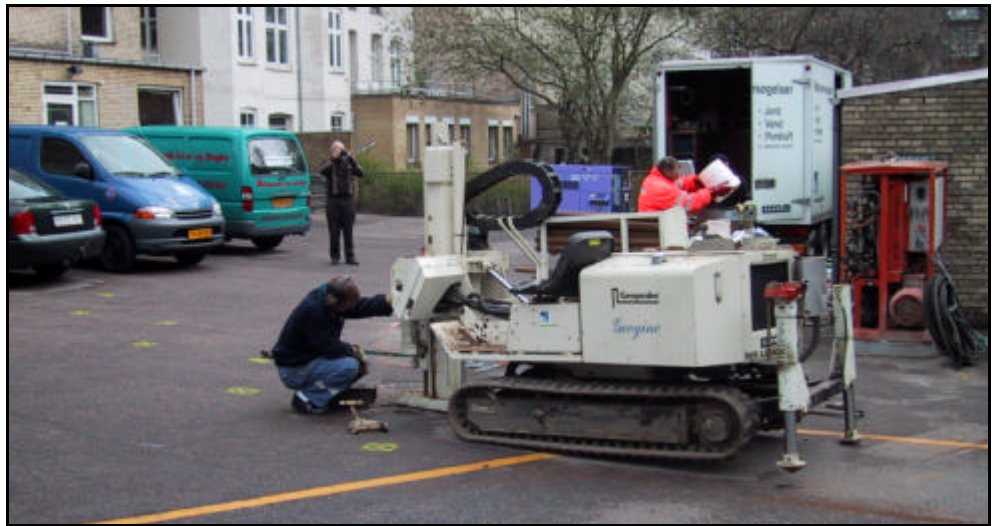
Figur 3.5 Injektion af substrat med Geoprobe
