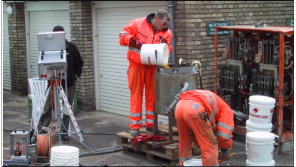
Figur 3.6 Omhældning af substrat (HRC/HRC Primer) til beholder. Til højre ses stempel pumpen med de 2 kredsløb. Til venstre ses kontrolenhet.
