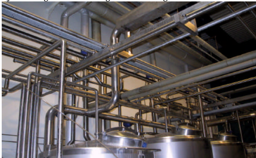
Figur 7.3: Loftet i blødgøringsrummet. Det fremgår tydeligt, at mærkning af rør ville mindske risikoen for fejltilslutninger.
