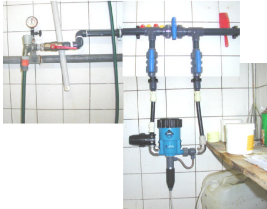
Figur 7.7: Et sammensat billede, der viser et eksempel på et medicindoseringsaggregat, som er tilsluttet direkte på vandforsyningsledningen. Der er ingen TBS-ventil til sikring af det lokale net og heller ingen kontraventil på aftapningen.
