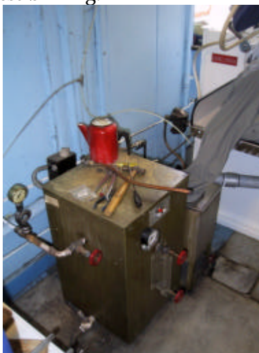
Figur 7.14: Billede af damp-aggregatet på et renseri. Aftapningen til aggregatet er sikret med luftgab.
