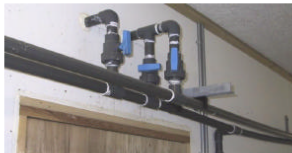
Figur 7.6: Ventiler, der kan drejes, så der ledes enten rent vandværksvand eller vand blandet med medicin ind i stalden.
