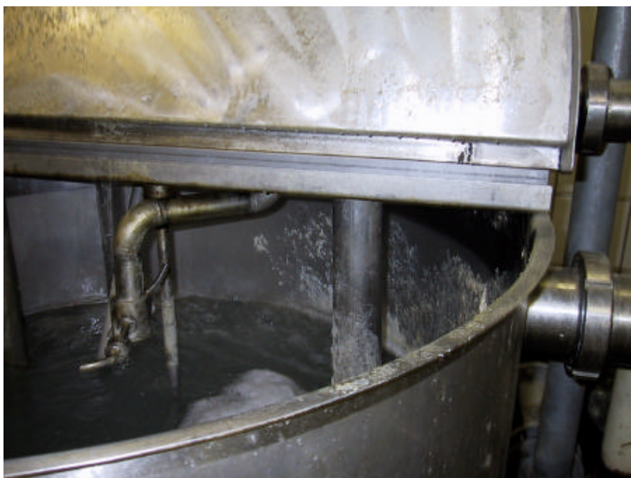
Figur 7.9: Luftgabet er blevet forlænget ind i proces tanken og dermed er kravene i DS 439 ikke overholdt. Overløbet er placeret højere end luftgabet.
