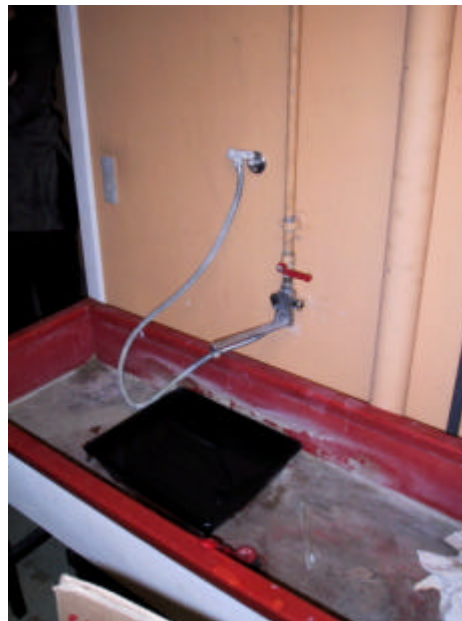
Figur 7.11: Billede af vask hos fotohandler, hvor der ikke er sikring mod tilbagestrømning.
