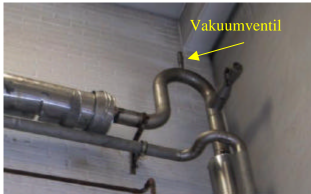
Figur 7.2: Vakuumventil for lille set i forhold til det benyttede rør.
