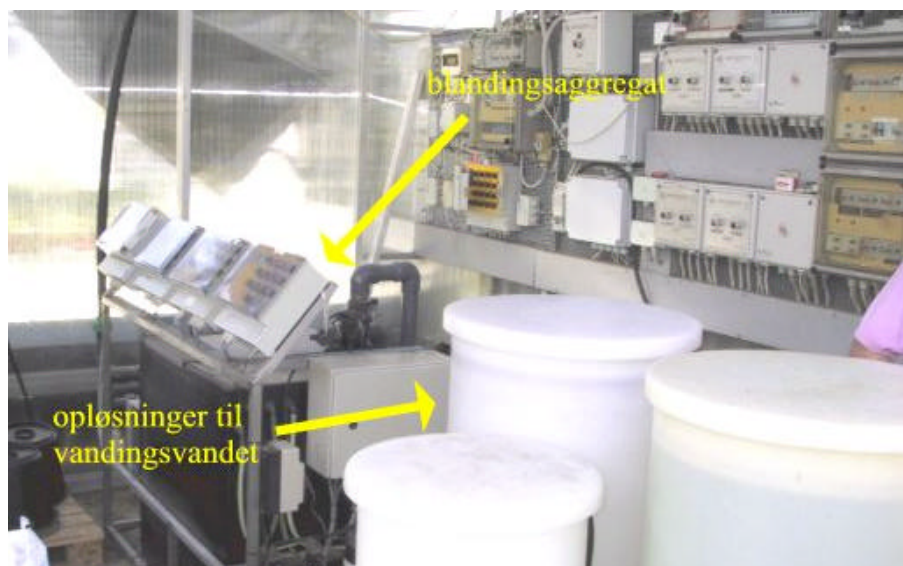
Figur 7.10: Viser blandingsaggregatet, hvor gødningsstoffer og syrer bliver blandet i vandingsvandet for at give planterne de bedste vækstbetingelser.
