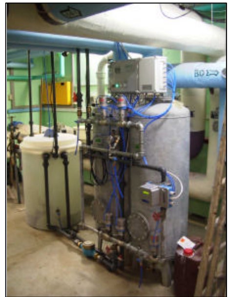
Figur 2.1: Sandfilteranlægget
