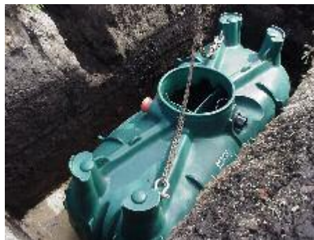
Figur 6. Error! Unknown switch argument. Tre-kammer bundfældningstank sættes
