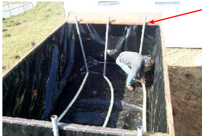
Figur 3.5 Containeren er blevet foret med en 0,75 mm membran. Bunddræn er etableret i de to celler.
