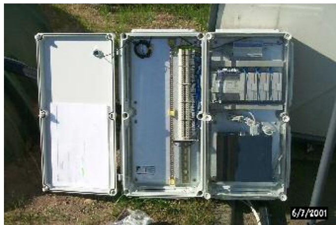
Figur 3.12 Forsøgsanlægget overvåges af en PLC'er, som er forbundet til en datalogger og et GSM modul for online opkobling via modem.
