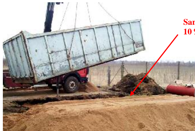
Figur 3.4 Sandpude med 10 % fald for fundament til container under opbygning.
