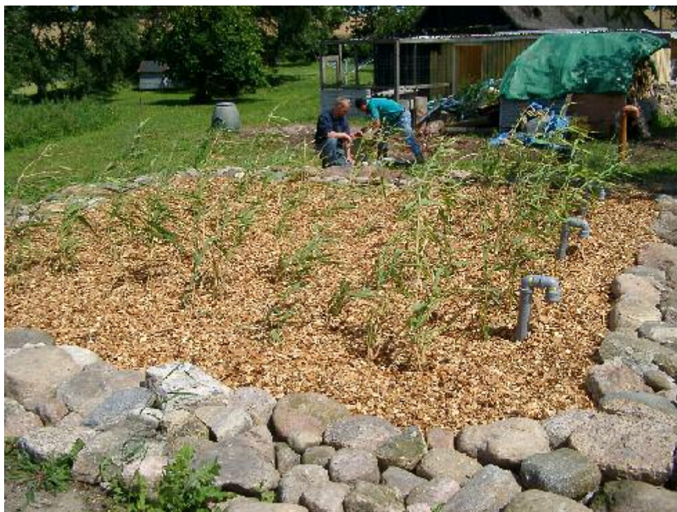
Figur 6.9 Det beplantede filter er isoleret mod frost af et 15-cm tykt lag træflis på overfladen. Membran er beskyttet mod lys ved dækning med en geotekstil og kampesten.
