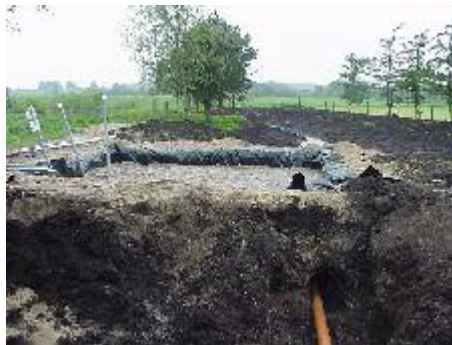
Figur 6. Error! Unknown switch argument. Grus er lagt ud med grab. Konvektionsrør er ført op. Udløbsrør er ført ud gennem membranen
