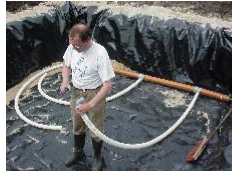
Figur 6. Error! Unknown switch argument. Membran og bunddræn udlægges.
