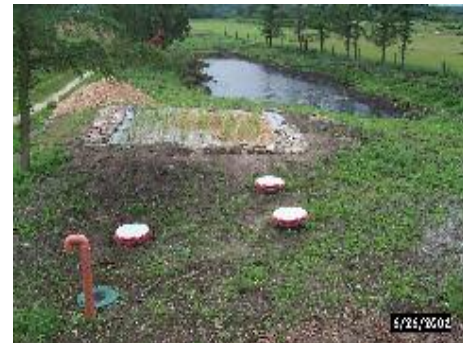
Figur 6. Error! Unknown switch argument. Filtret er beplantet med tagrør med en tæthed på 6 planter pr m 2 . I baggrunden ses den nyanlagte sø som er recipient for renseanlægget.
