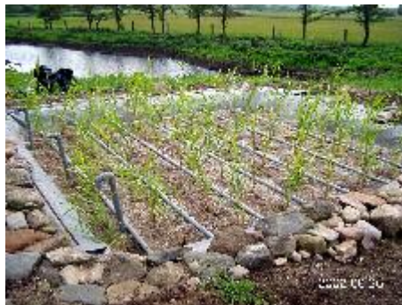
Figur 6. Error! Unknown switch argument. Filtret er beplantet med tagrør med en tæthed på 6 planter pr m 2 . I baggrunden ses den nyanlagte sø som er recipient for renseanlægget.
