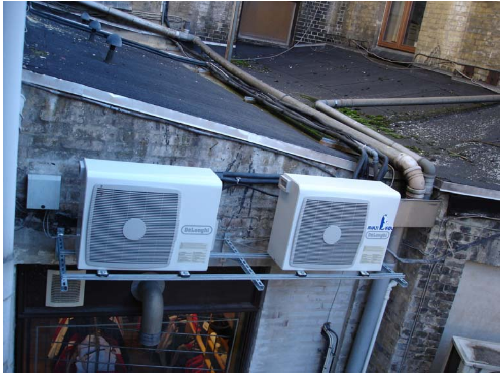
Figur 6.1: Udedele placeret på baggårdssiden af bygningen.
