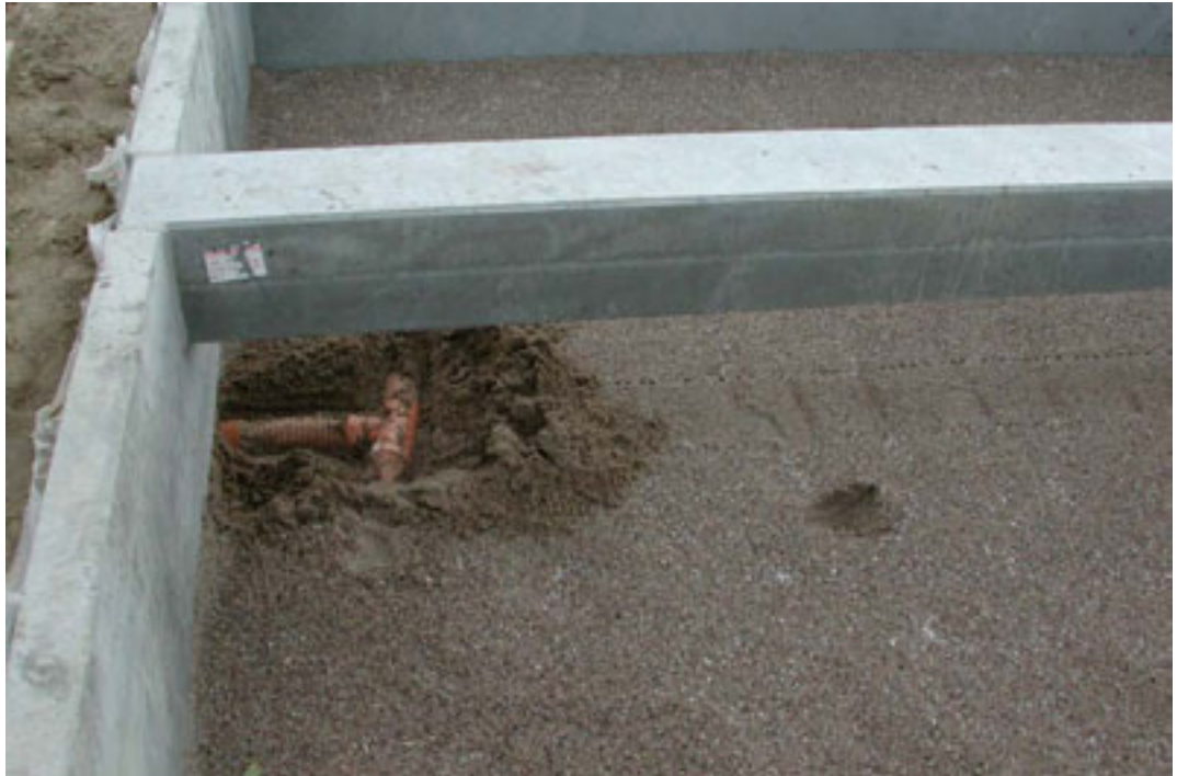
Figur 6.1. Opbygning af biobed af elementer fra betonfirmaet Perstrup A/S. Dimension 4 x 3,8 meter, 0,8 meter dyb. Dræn i bunden ligger i 15 cm grus og fører til samlebrønd. Gruset dækkes af et 10 cm stampet lerlag.
