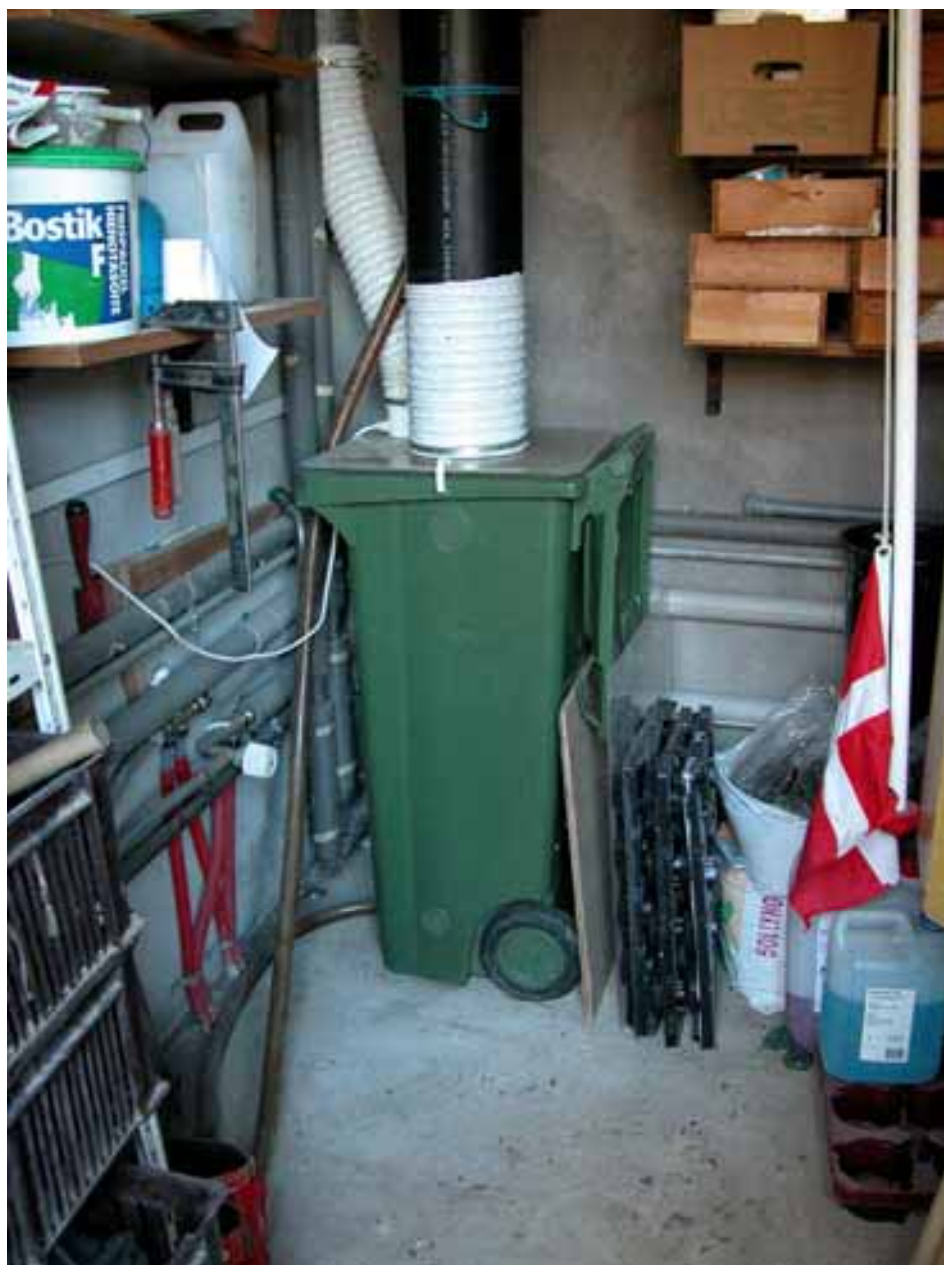
FIG. 3.1. 140 L OPSAMLINGSBEHOLDER I ANLÆG NR. 4
