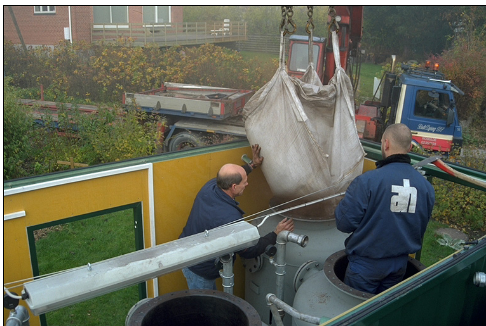
Figur 2.2 Påfyldning af jernspåner
