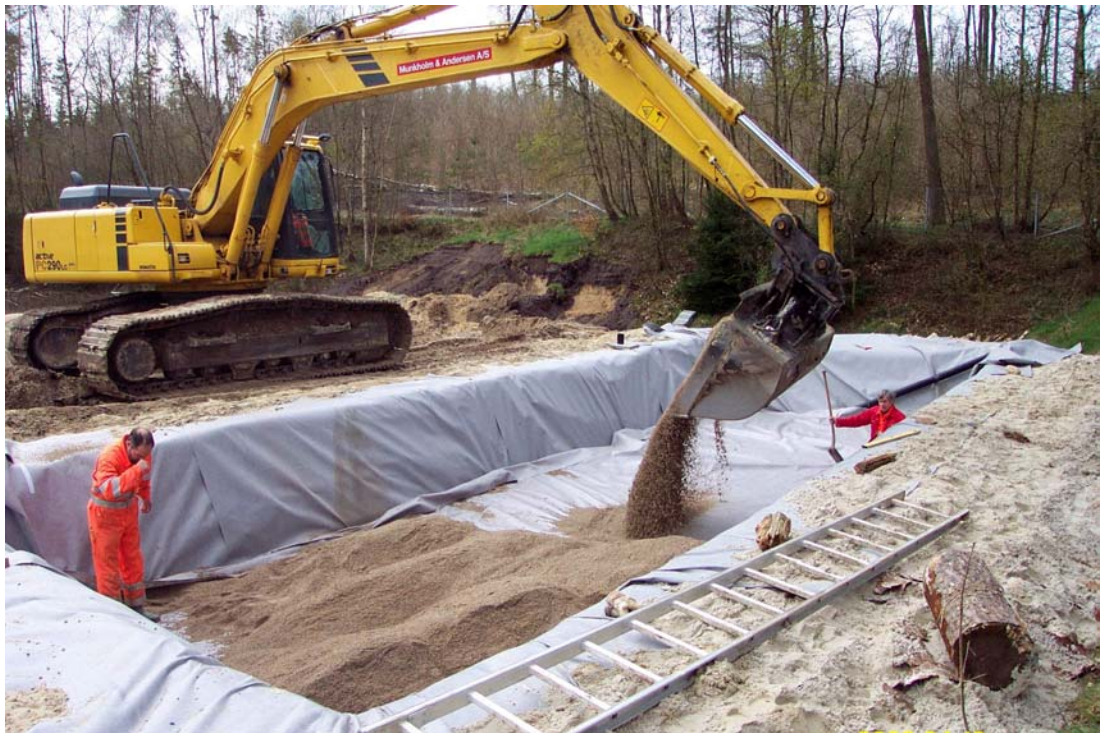
Figur. 13. Etablering af biologisk sandfilter – Udlægning af filtergrus.
