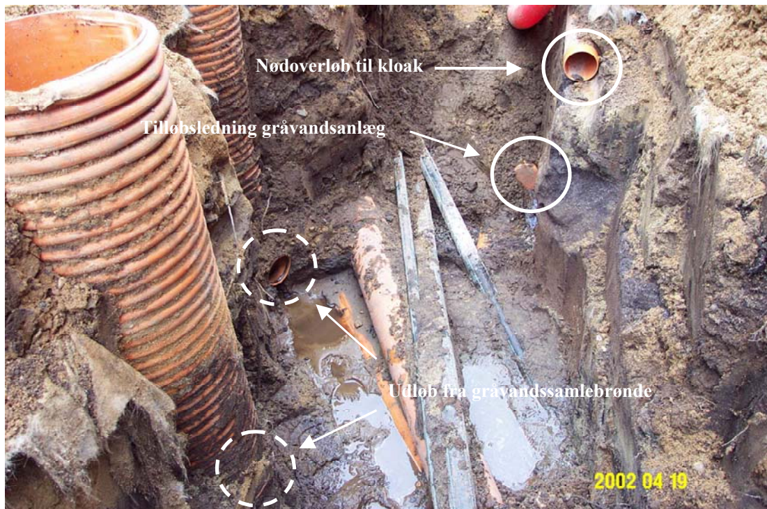
Figur 12. Etablering af kabelrør og spildevandsledninger ved baderumsbygning.
