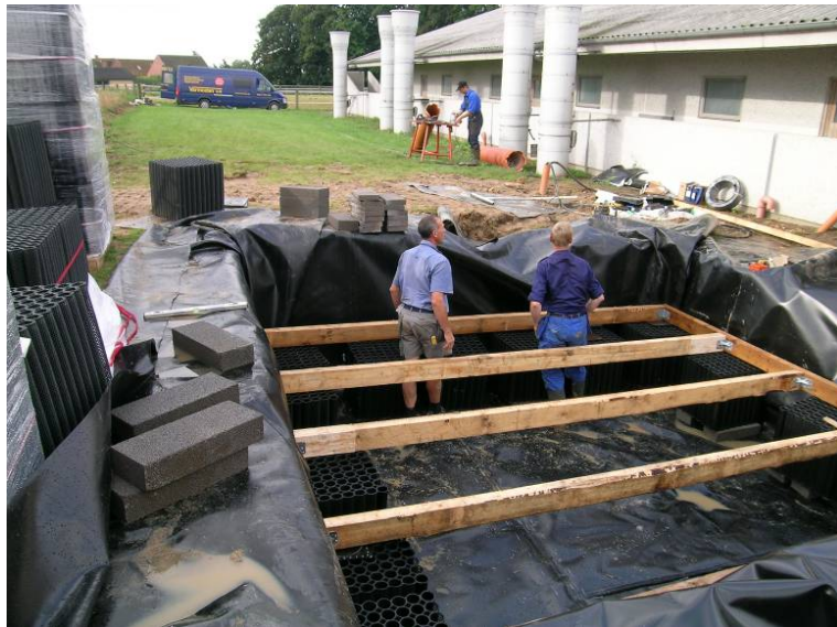
Figur 3.3 Opbygning af biofil tret.
