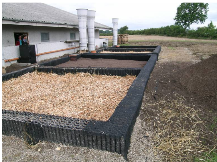
Figur 3.7 Det færdige anlæg, hvor fil trenes andet rensetrin i form af halm + træflis samt LECA er etableret ovenpå bioblokkene.
