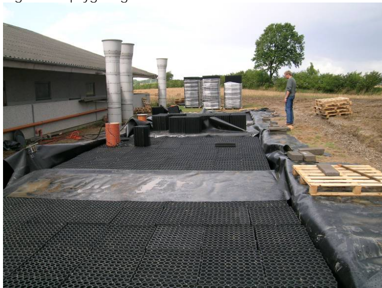
Fig. 3.4 Viser opbygningen af fil trenes første rensetrin bestående af biobløkke.
