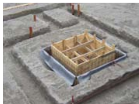
En diffusionshæmmende membran etableret under en kommende elevatorskakt
