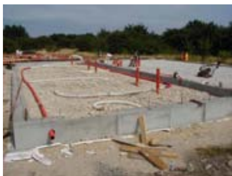
Etablering af ventilationsdræn i det kapillarbrydende lag i en ny gulvkonstruktion
