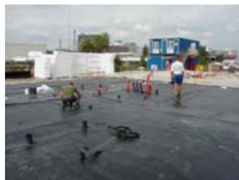
Udlægning af diffusionshæmmende membran ifm. med etablering af ny bygning
