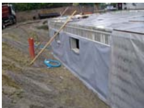
Montering af diffusionshæmmende membran på kældervæg. Membranen svejses sammen med den membran, der ligger i gulvkonstruktionen, for at sikre en tæt kældkonstruktion
