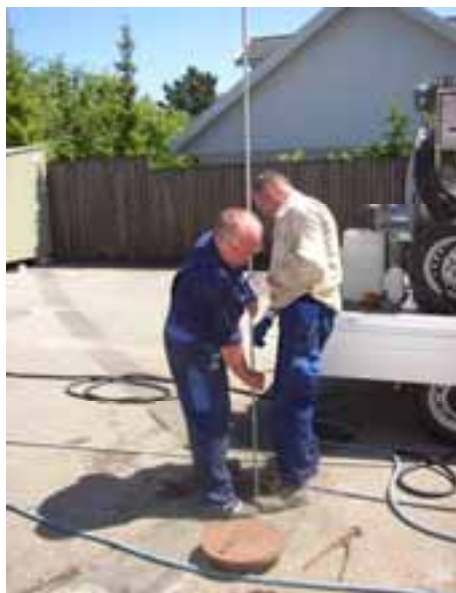
FOTO 5.9 OG 5.10. REGENERERING AF BORINGER, STEMPEL TIL INJEKTION AF LBA
