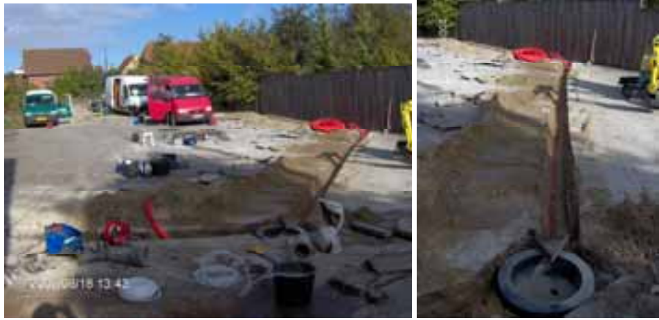
FOTO 4.6 OG 4.7. ETABLERING AF LEDNINGSFØRING OG EL-TRACING AF PEX-RØR
