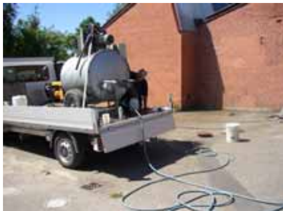
FOTO 5.8. TØMNING AF FILTRE FØR REGENERERING
