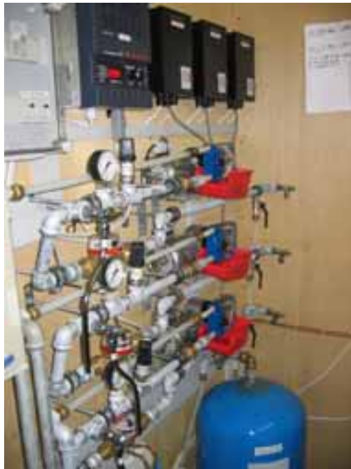
FOTO 4.5. FREKVENSTYRING AF PUMPER OG MANUEL AFLÆSNING AF TRYK OG FLOW
