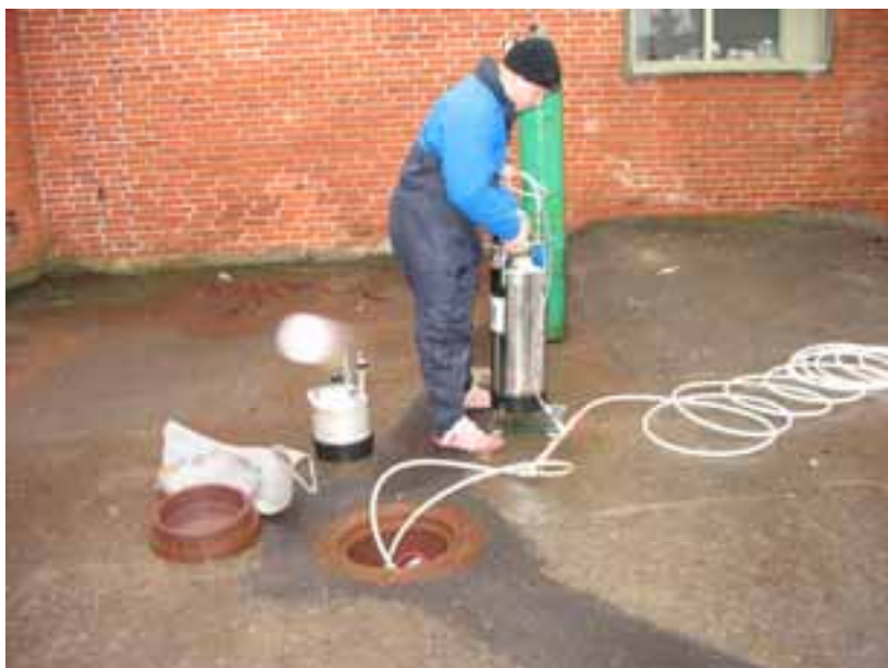
FOTO 5.2. INJEKTION AF KB-1 VED HJÆLP AF NITROGEN
