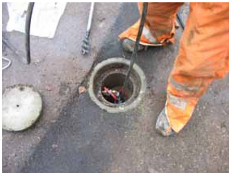
FOTO 5.3. BØRSTE TIL MEKANISK RENSNING AF INJEKTIONSBORING
