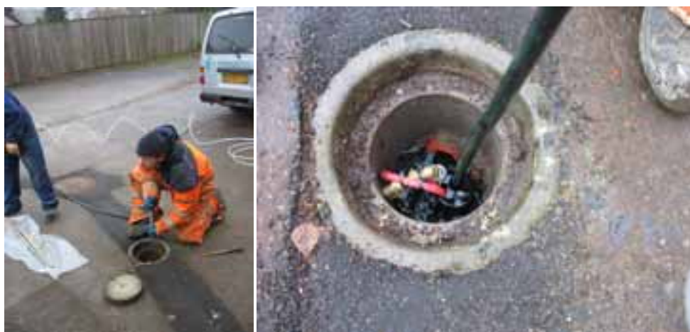
FOTO 5.4 OG 5.5. MEKANISK RENSNING OG SMUDS OPRENSET FRA FILTER
