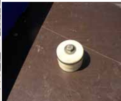
FOTO 5.9 OG 5.10. REGENERERING AF BORINGER, STEMPEL TIL INJEKTION AF LBA
