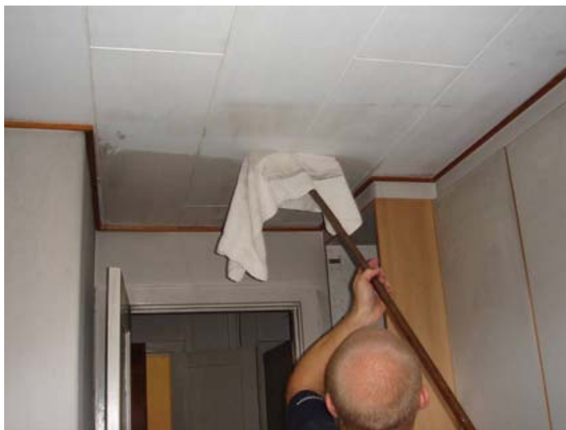
Foto 2: Rengøring af loft i sodskadet lejlighed.
