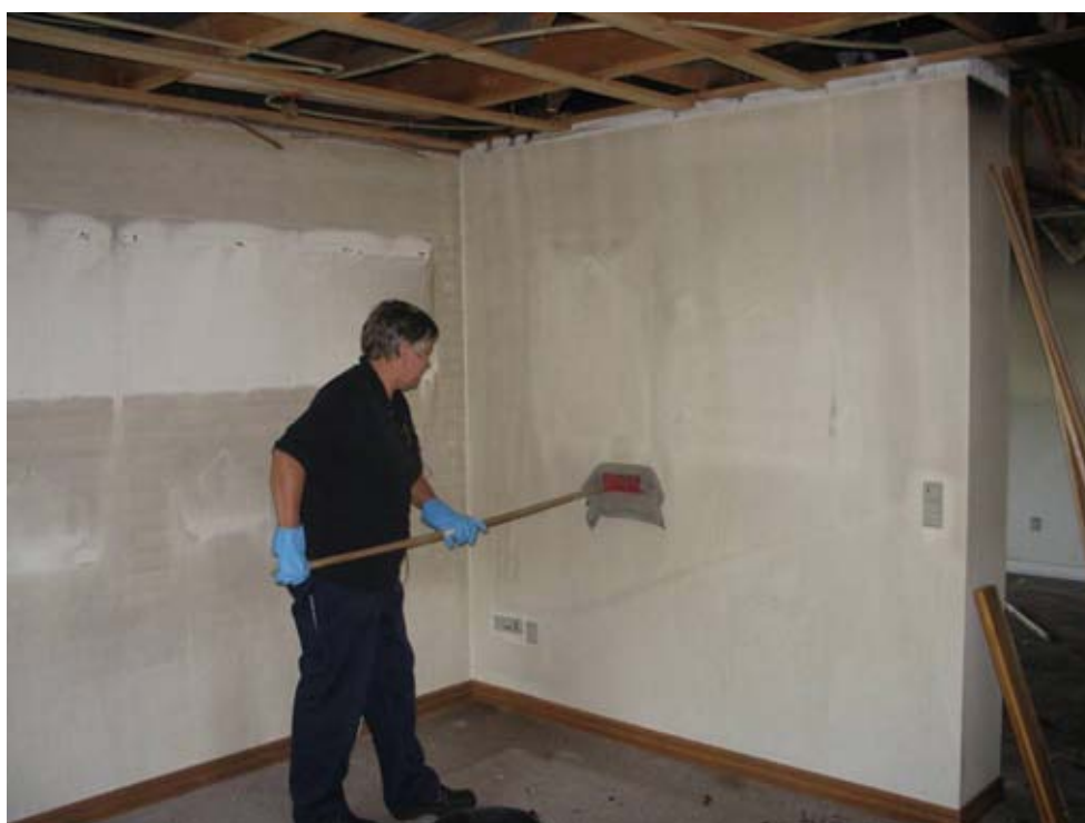
Foto 6: Rengøring af vandskuret væg med kost og klud.
