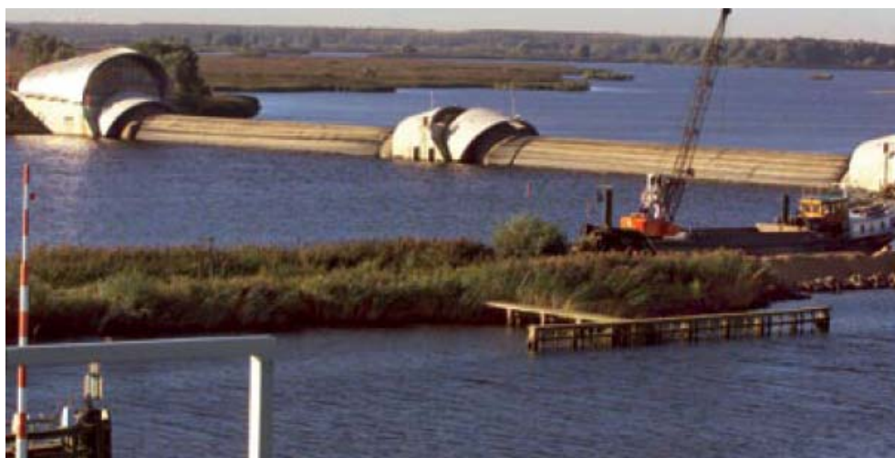
Figur 10: Balg-gate ved Ramspol i Holland.
