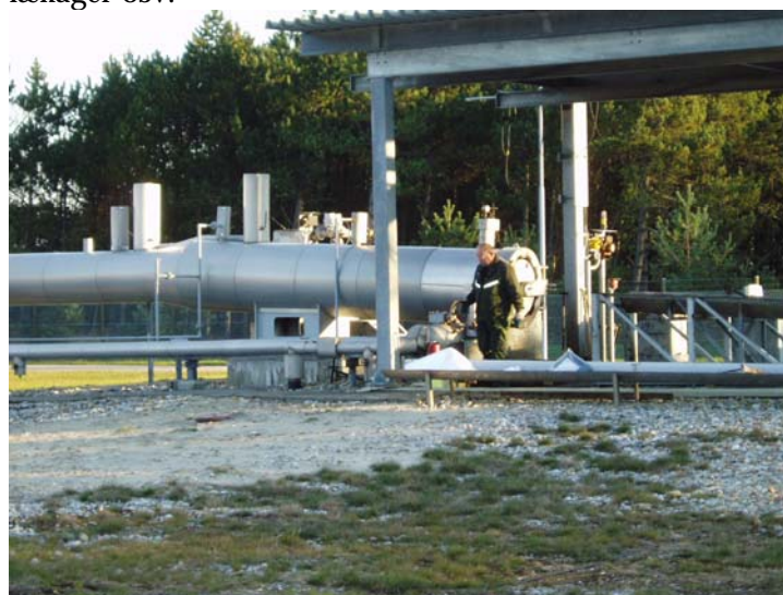
Figur 5. "Grisesluse" til modtagelse af grise. DONG Energy's olierørledning (Filsø).
