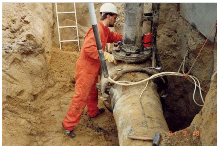
Figur 1. Nedgravet pipeline. Det lodrette rør er en del af en (kugle)ventil (DONG Energy A/S).
