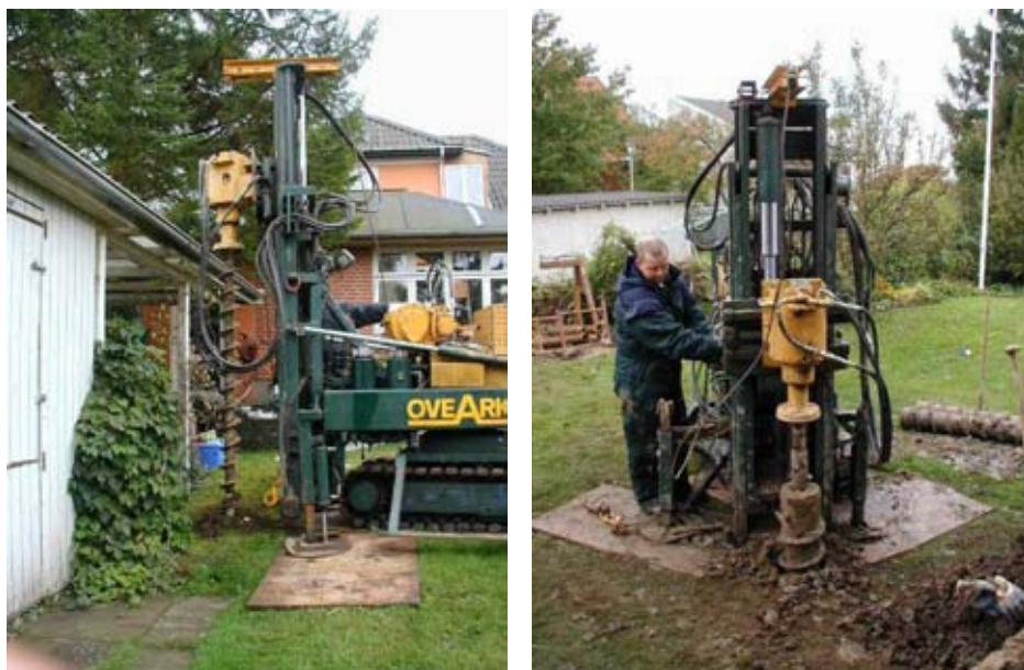
Figur 4.7: Udførelse af monitoringsboring med minirig.
