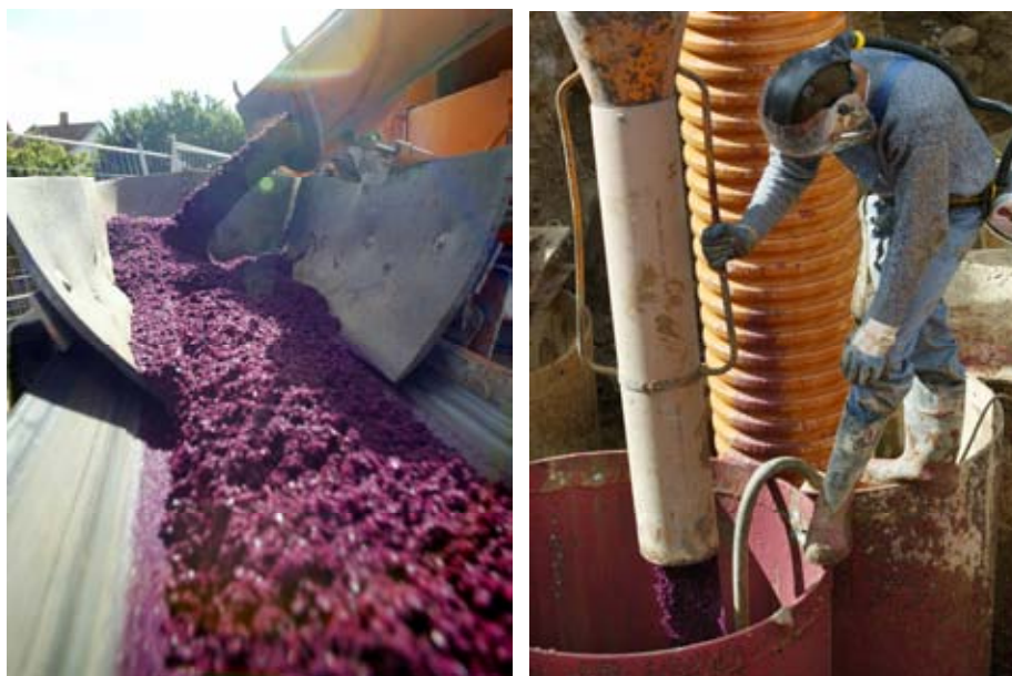
Figur 5.11: Indbygning af tilbagefyldningsmaterialer (tydelig violet farve).
