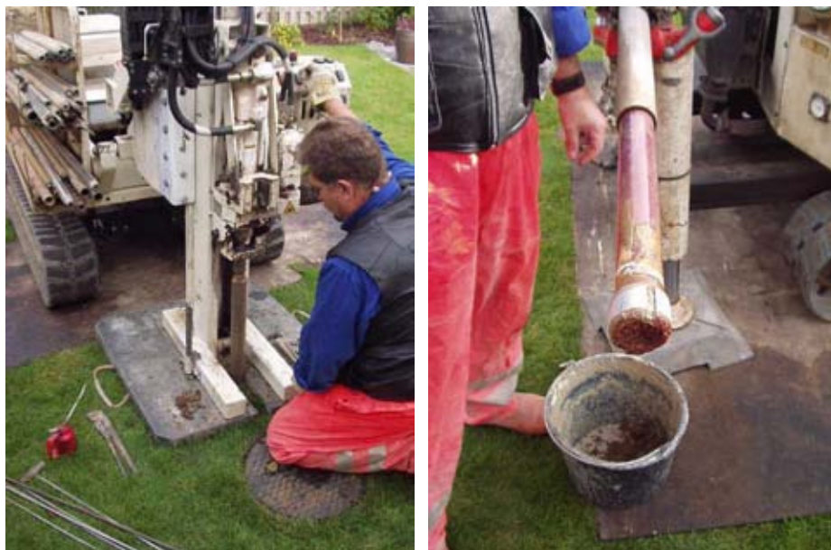
Figur 5.10: Udtagning (tv.) og forsegling (th.) af intakt jordkerne med geoprobedstyr.
