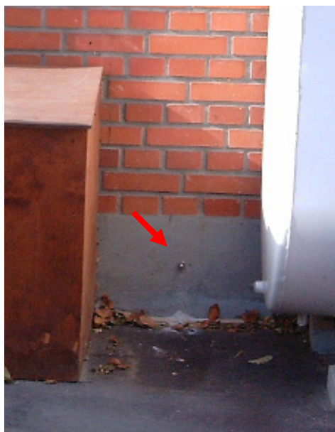
Figur 4.10: Fixpunkt på østsiden af renseribygningen (FixA).
