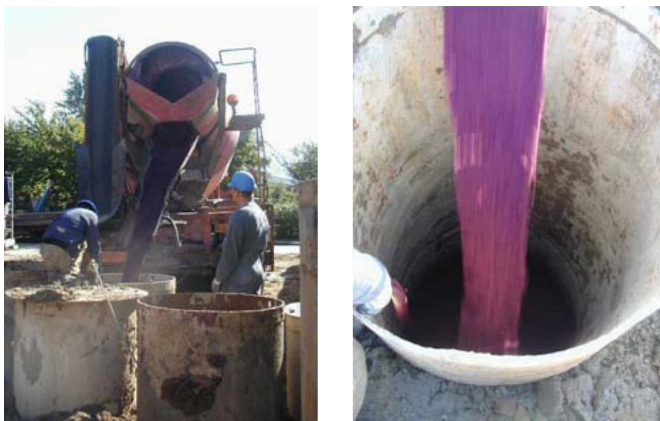
Figur 4.2.: Tilbagefyldning af sand, grus, vand og kaliumpermanganat.
