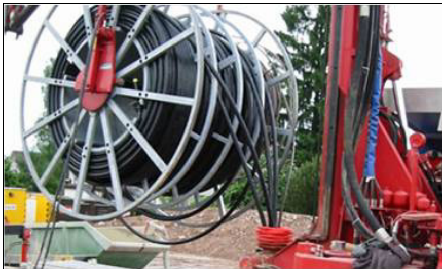
Figur 11 Afrulning af varmeslanger, installation af anlægget i en boring. Fra Rotek A/S.
