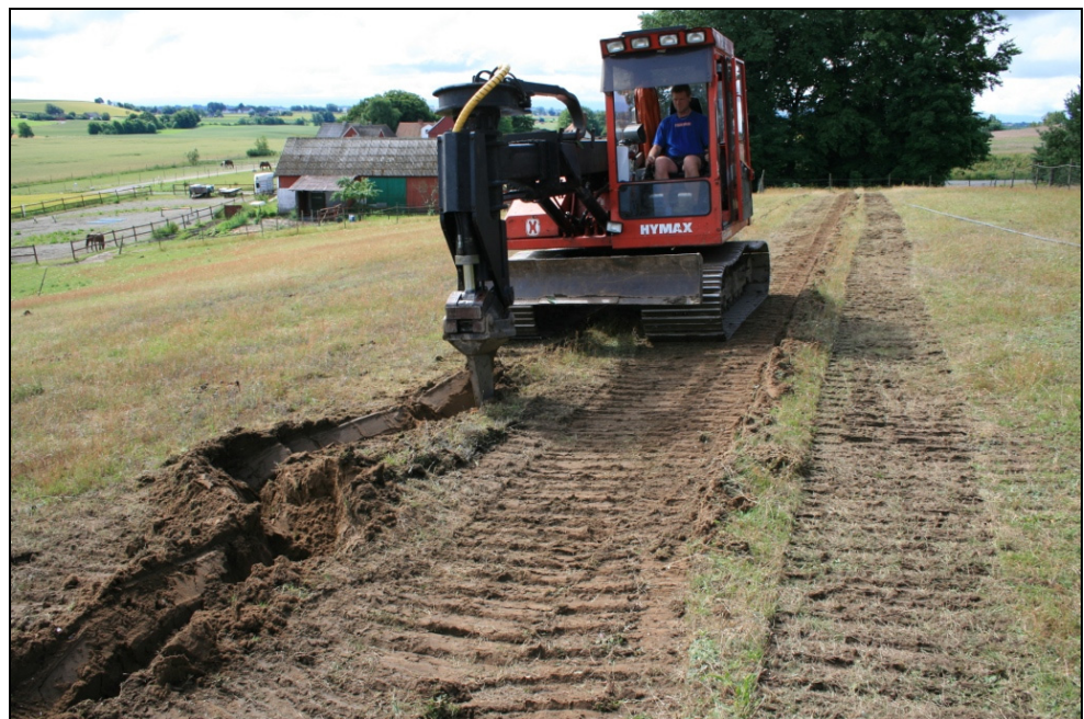
Figur 5 – først trækkes en grubetand igennem jorden for at få åbnet og samtidig undersøge jorden for sten mv.
