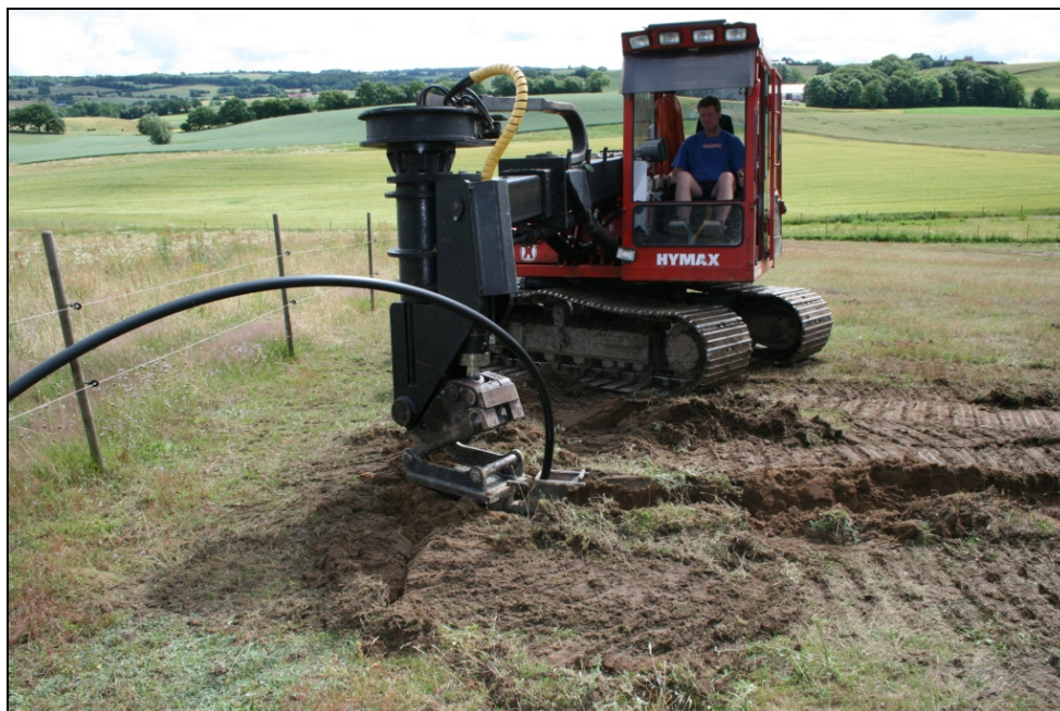
Figur 6 Nedlægning af slangen.
