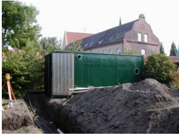
Foto 4.4 og 4.5 Placering af behandlingscontainer i baggården til Grønnegade 41 (venstre) samt indretning af manifold til vakuumeksaktion og airsparging
