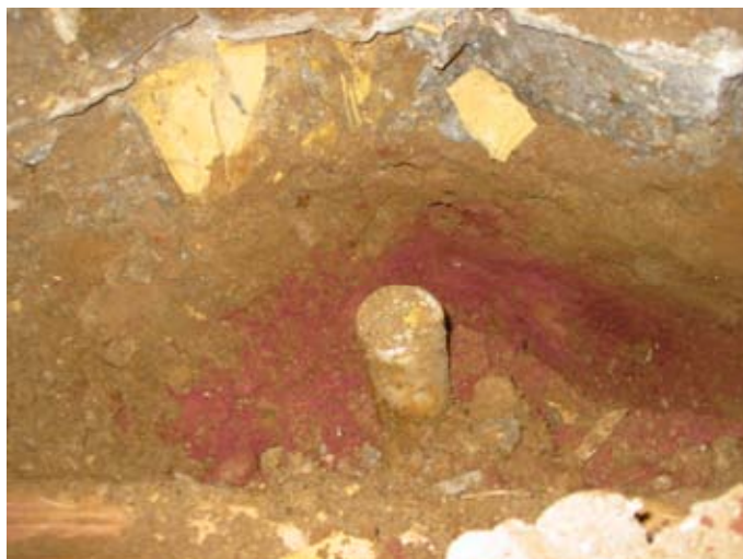
Foto 5.1 Rødfarvning af jorden ved injektion af kaliumpermanganat.
