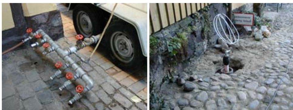
Foto 5.3 og 5.4 Manifold samt fittings til sammenkobling af injektionsslange med filterør
