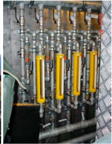
Foto 4.4 og 4.5 Placering af behandlingscontainer i baggården til Grønnegade 41 (venstre) samt indretning af manifold til vakuumeksaktion og airsparging
