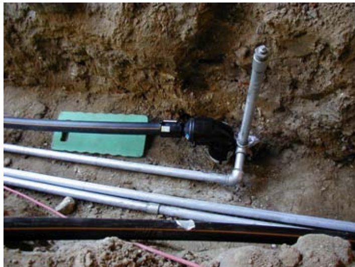
Foto 4.1 Ledningsføring, kombinerede vacuum- og airspargeboringer
