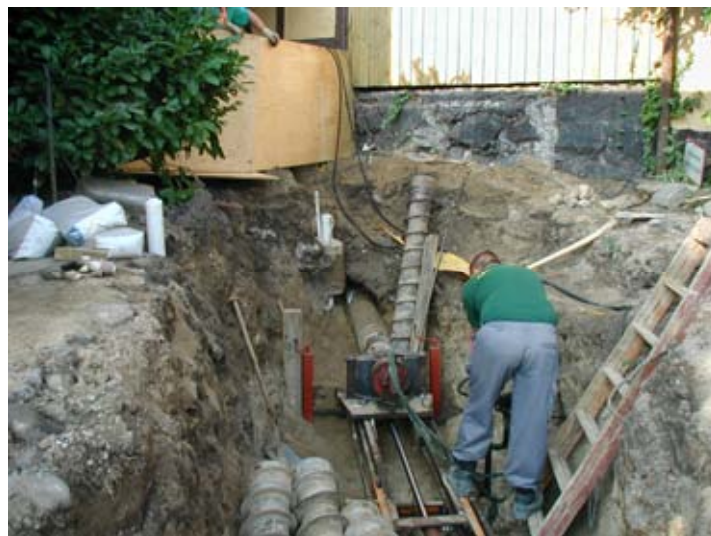
Foto 4.2 Etablering af horisontale boringer
