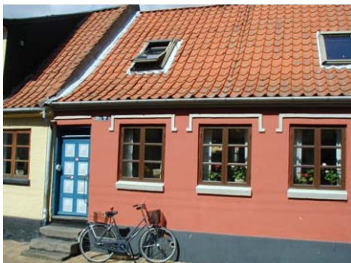
Foto 2.4 Grønnegade 39, Forhus set fra Grønnegade
