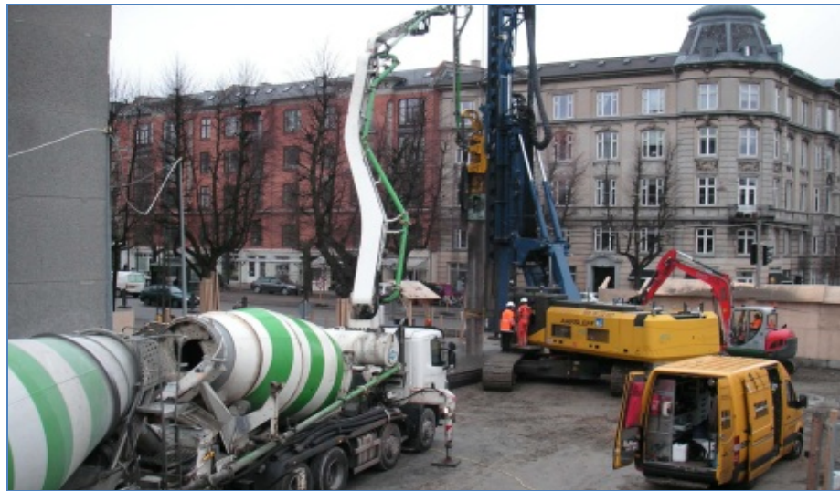
Figur 8. Boring af sekantpæle til cityringen i København 2011. Kilde: Per Aarsleff
