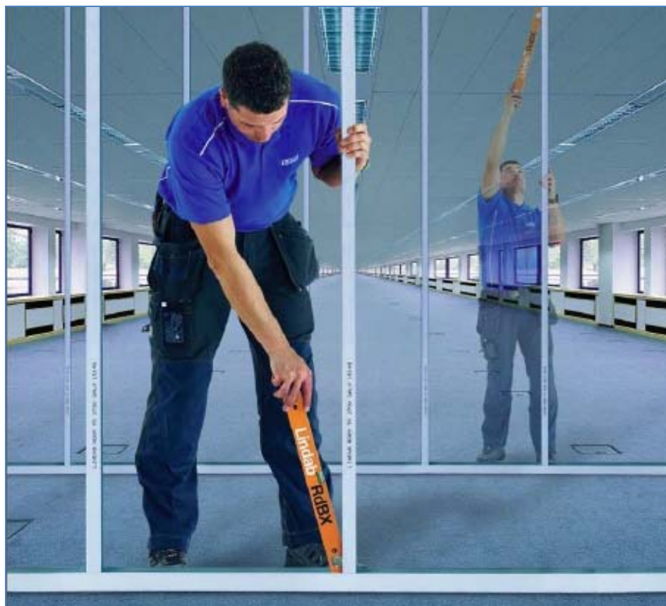
Figur 17. Lindab RdBX stål lægter, som kan tilpasses på stedet uden brug af støjende værktøj. Kilde: Lindab.
