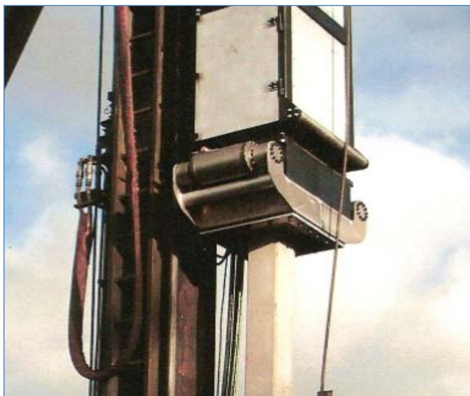
Figur 14. Støjdæmpet hammer til ramning af betonpæle. Indkapslingens nederste del kan muligvis udvikles til at passe til spunsjern. Kilde: Per Aarsleff A/S.
