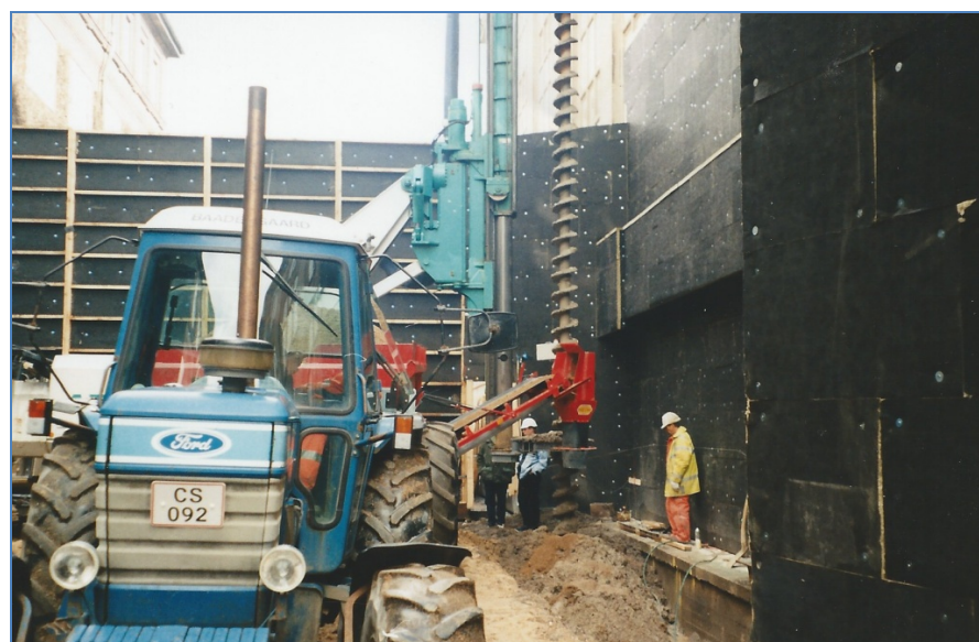
Figur 12. Støjskærm omkring byggeplads til den eksisterende metro i København
