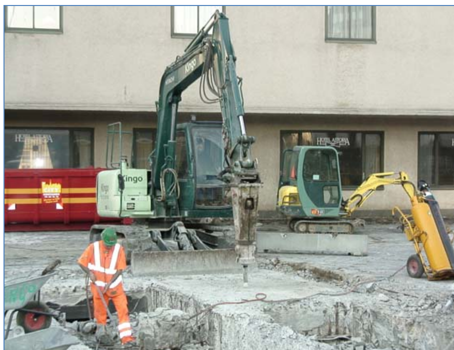
Figur 2 Hydraulisk hammer. Kilde: Kingo Karlisen
