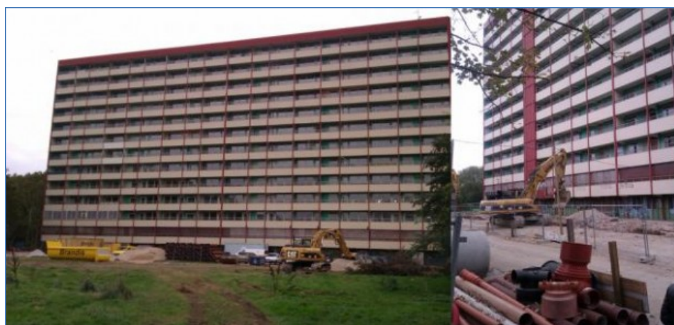
Figur 20. Højhusene Ruskær og Agerkær i Rødovre skal fjernes ved sprængning.
