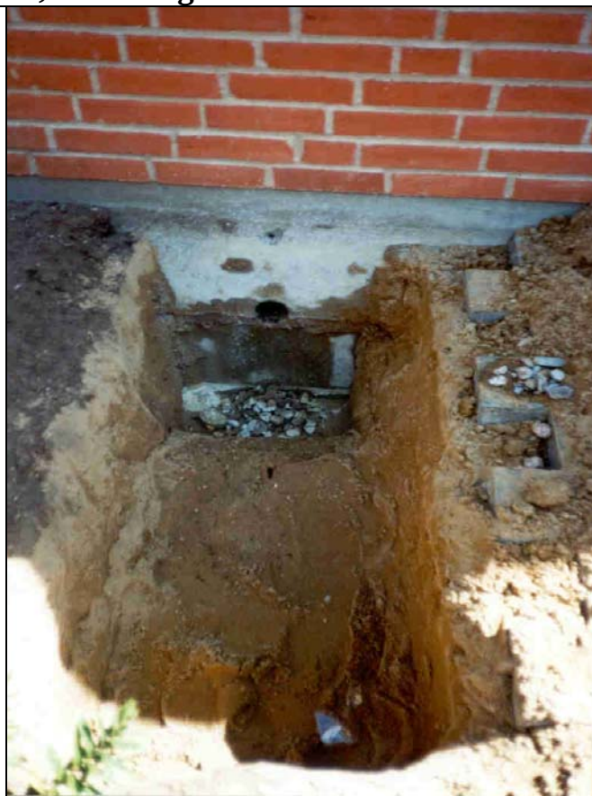
Frigravning af fundament (installation af dræn)
