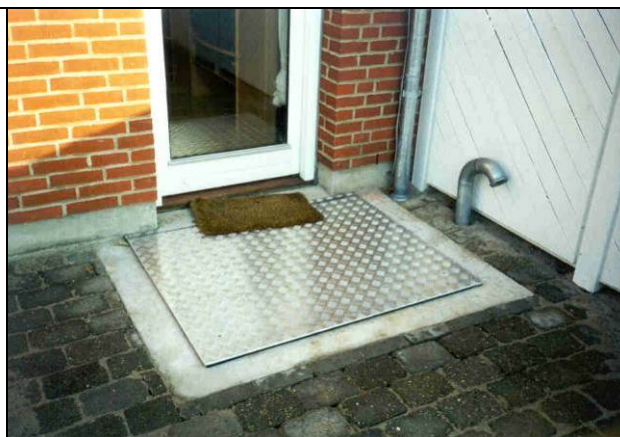
Lydisoleret dækplade i aluminium
