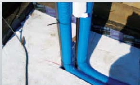
Eksempel på, hvor meget slangerne kan bøjes.
