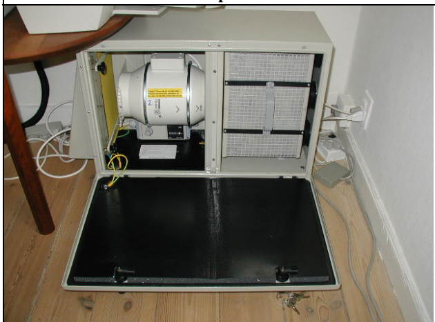
Opbygning af luftrenser (ventilatorenhed tv. og kulfilter th.)
