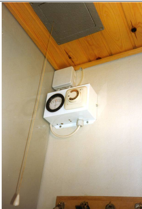
Kontrolboks med omdrejningsregulator og manometer, monteret i bryggers
