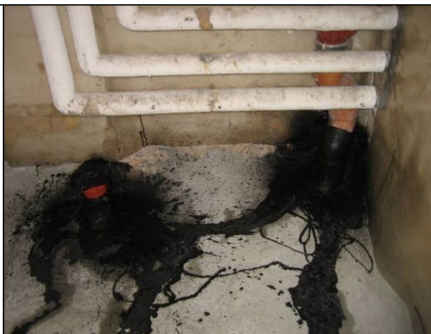
Tætning af rørgennemføringer
