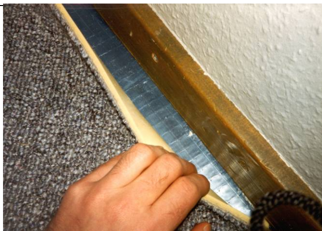
Membran monteret under tæppe i eksisterende bolig
