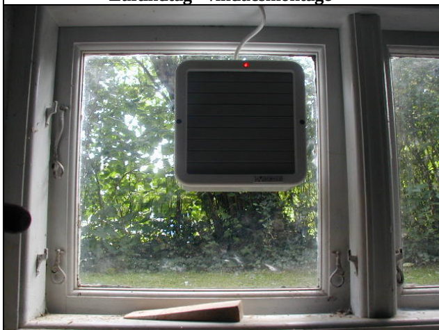
Ventilator – vinduesmontage, slukket
