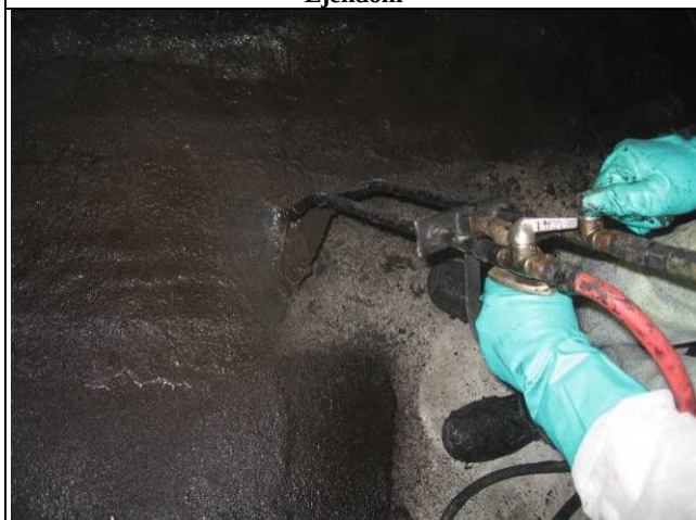
Udsprøjtning af membran
