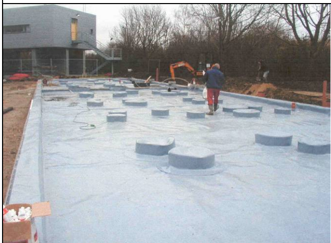
Membranen udlagt på terrændæk (med påsejsede membrankraver)
