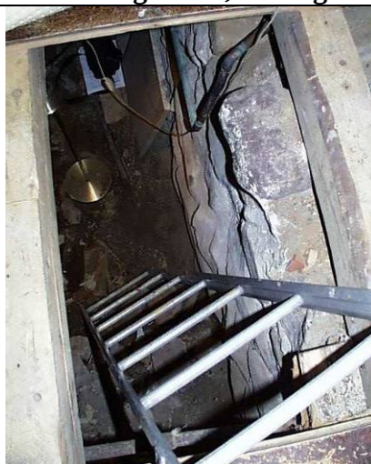
Nedgang til lukket kælder
