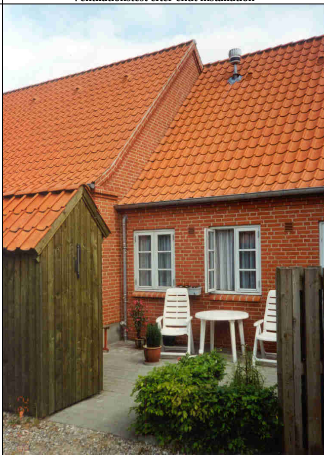
Afkastsrør og vindhætte
