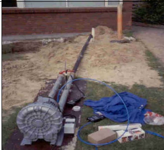
Maskinel indboring af dræn
