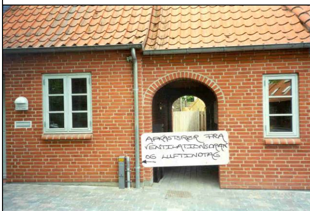
Afkastsrør fra ventilationsdræn samt luftindtag
