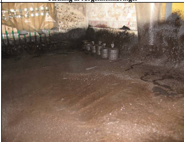
Færdig membran med rørgennemføringer
