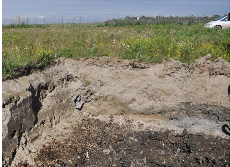
- Billede 3. Udgravning på Celle 2.1.4
