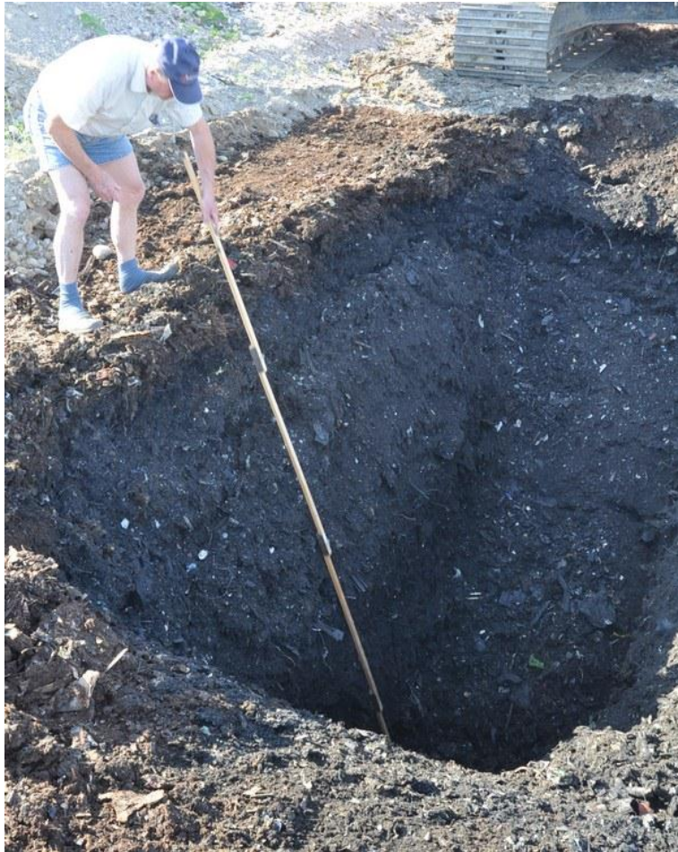
Billede 2. Udgravning på Celle 2.1 (ca. 2,5-3,5 m dybde)
