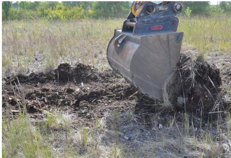
Billede 5. Udgravning på Celle (1.5.1)
