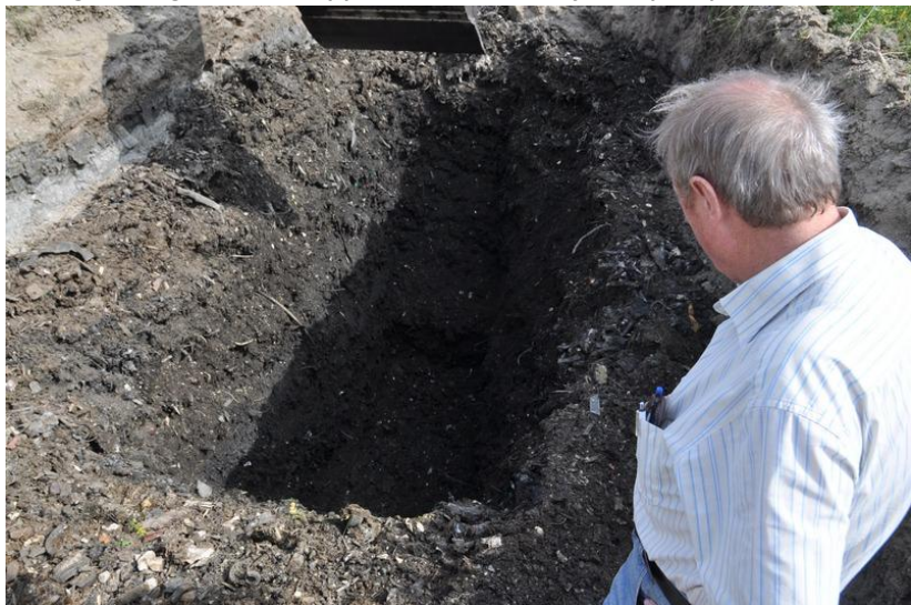
Billede 4. Udgravning på Celle 2.1.4
