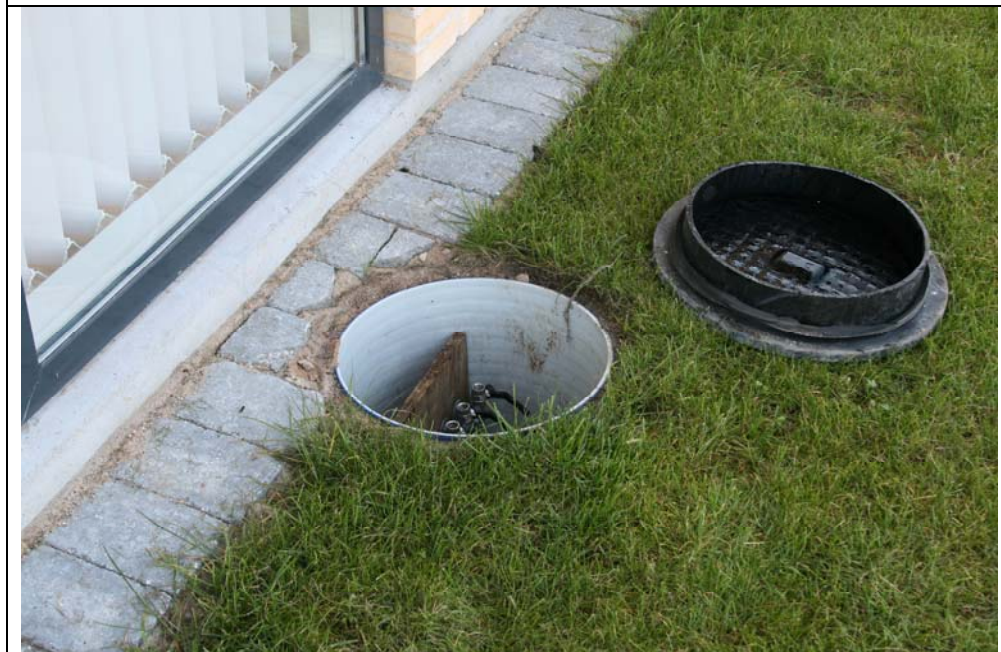
2: Målebrønd m præinstallerede målepunkter i det kapillarbrydende lag.
