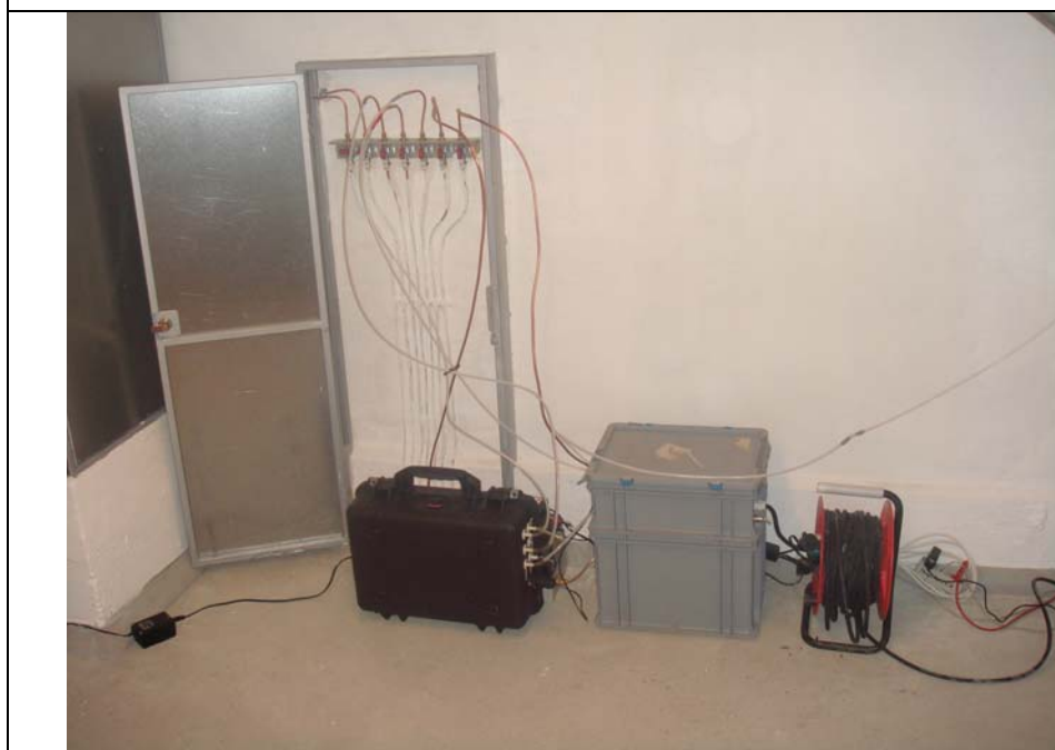
2: Installation af måleudstyr i vaskekælder v. præinstallerede målepunkter i det kapillarbrydende lag, kælderrum 101.
