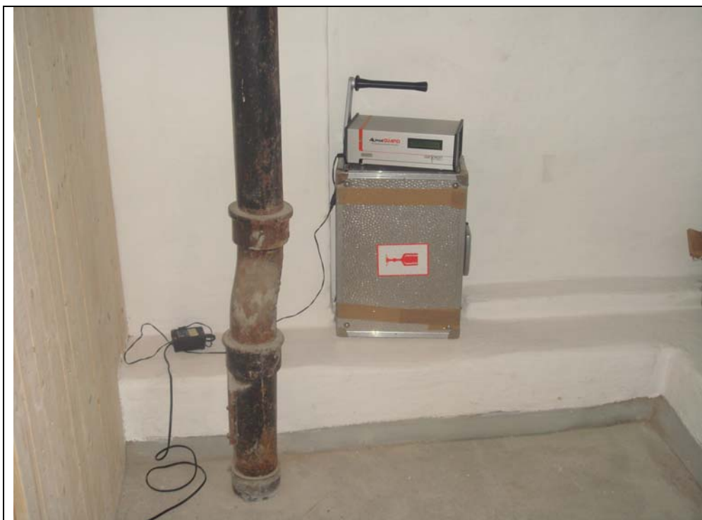
3: Installation af AlphaGuard måler, kælderrum 102.
