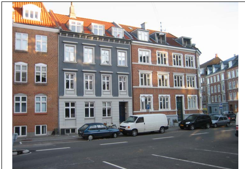
1: Frederiksbjerg Torv 10, sydlig facade, set fra syd.
