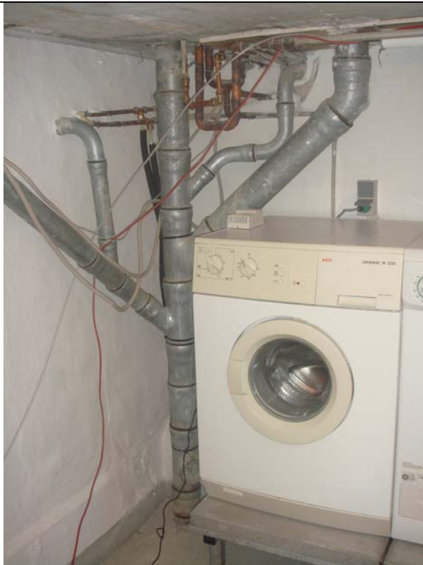
5: Installation af Ramon måler, vaskekælder, kælderrum 101.
