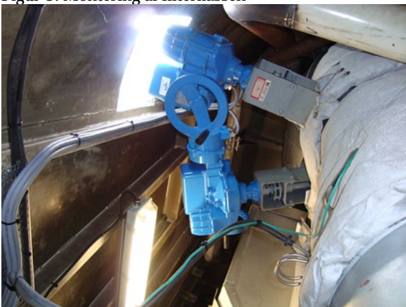
Figur 9: Automatisk røggasventil og styretavle
