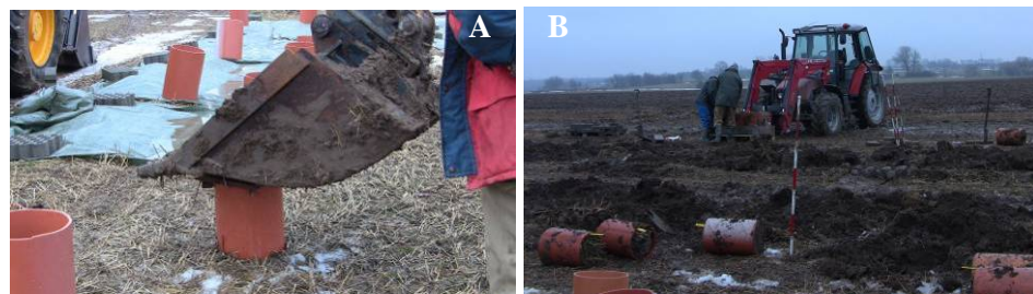
FIGUR 2-9. A: ILLUSTRATION AF FREMGANGSMÅDEN VED UDTAGNING AF JORDPRØVER MED GRAVEMASKINE. PRØVECYLINDRE AF PVC TRYKES VERTIKALT NED I JORDEN (VANDINDHOLD \cong MARKKAPACITET) VHA. RENDEGRAVER. B: DE RELATIVT TUNGE JORDPRØVER (CA. 65-70 KG STK -1 ) BLEV GRAVET OP MED HJÆLP AF RENDEGRAVEREN OG FRAGTET HJEM PÅ FRONTSKOVLEN AF EN TRAKTOR.
