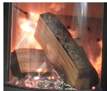
Eksempel på genfyring med større træstykker.
