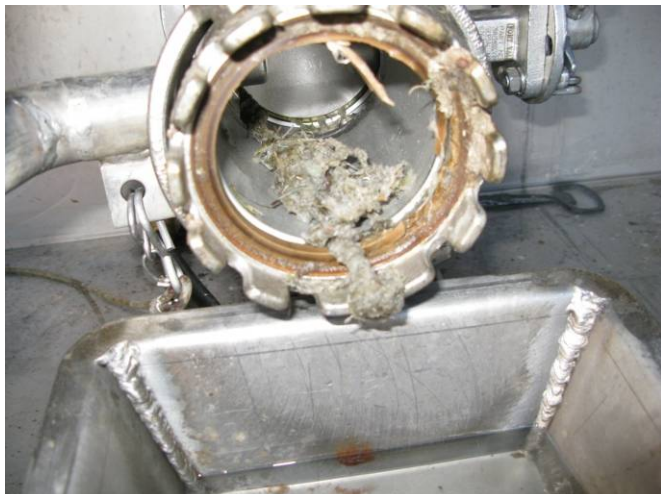
Figur 13: Problemer med "hårbolde" i biogasanlæg.
