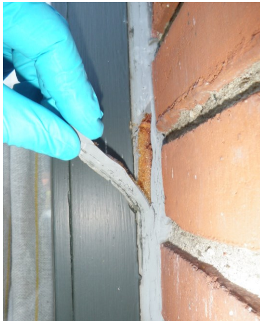
Billede 2 Eksempel på PCB-holdig elastisk fuge
