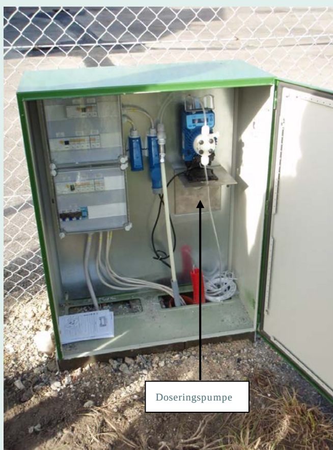
Billede 5 Skab med doseringsenhed (passiv fase)
