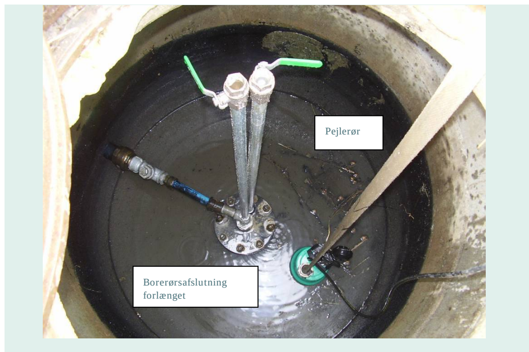
Billede 3 Ændret bestykning af injektionsboringer (aktiv fase)
