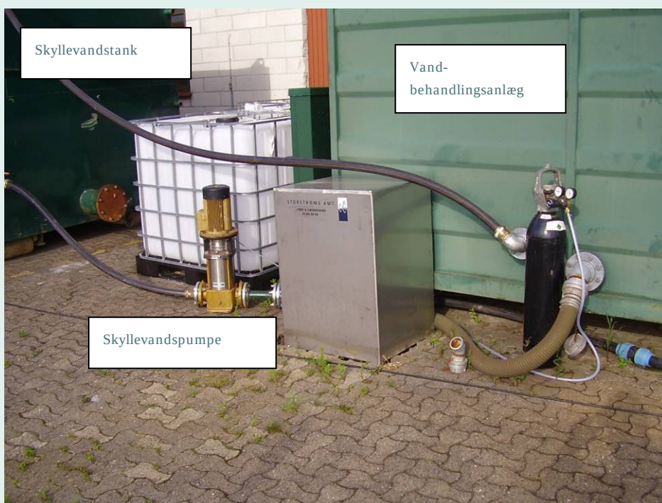
Billede 2 Skyllevandstank og skyllevandspumpe (aktiv fase)
