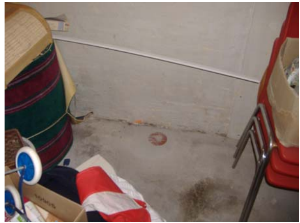
Rum H: Målepunkt 18 (overgang mellem gulv og væg)
