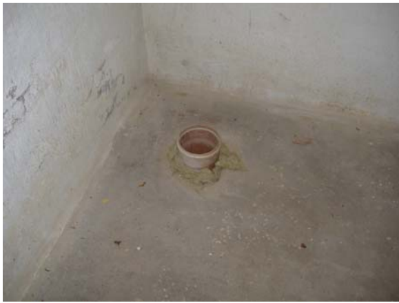
Rum E: Målepunkt 17 (ved/i rørgennemføring)
