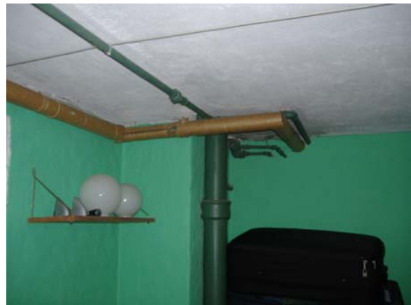
Rum G: Skorsten og kloakgennemføring
