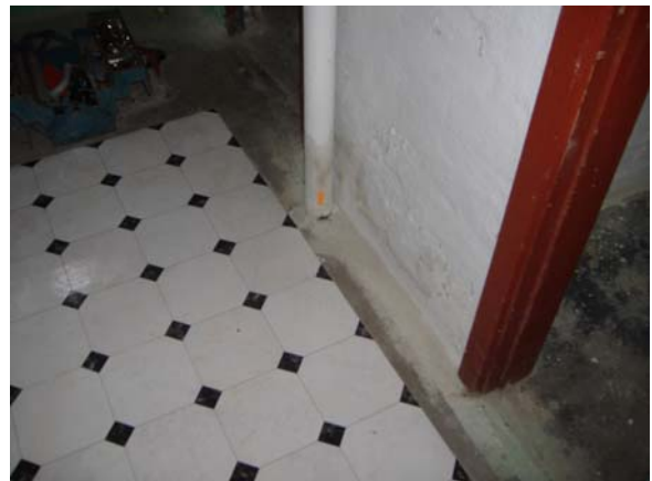
Rum G: Målepunkt 6 (rørgennemføring gennem gulv)
