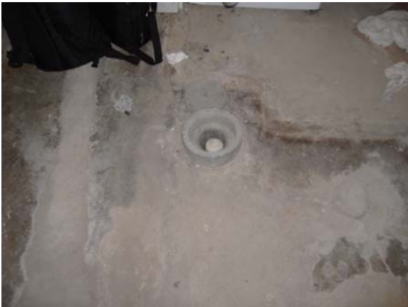
Rum A: Målepunkt 3 (ved boring)
