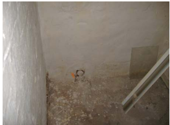
Rum H: Målepunkt 14 (ved aflukket rørgennemføring)
