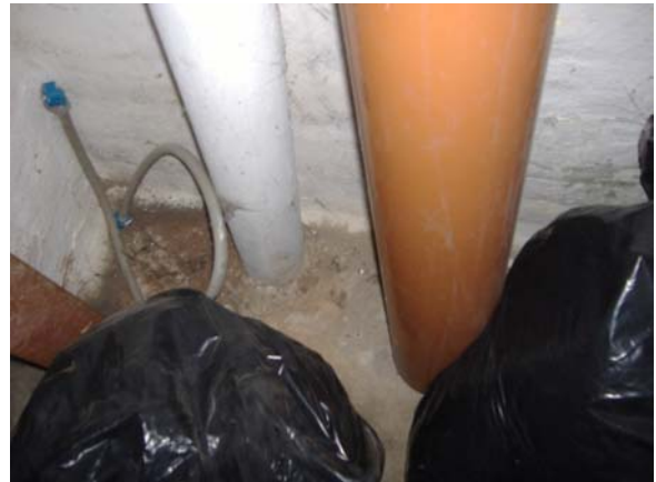
Rum C: Målepunkt 4 (rørgennemføring gennem gulv)
