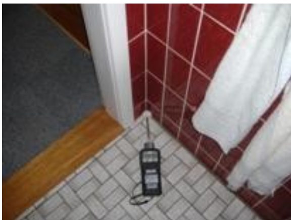
FIGUR 10 MÅLING VED BRUG AF PPB-PID INSTRUMENT AF TYPEN PPB-RAE VED OVERGANG MELLEM GULV OG VÆG I ET BADEVÆRELSE.
