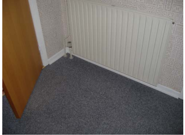
Målepunkt 14 under radiator - rum F
