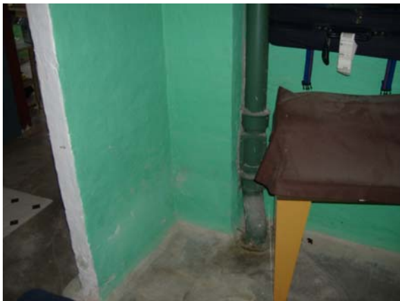
Rum G: Skorsten og kloakgennemføring
