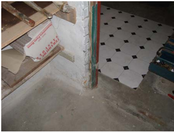
Rum F: Målepunkt 9 (i væg mellem mursten)
