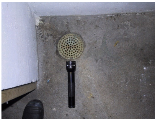
BILLEDE 50 GULVAFLØB AF PLASTIK SIKRER IKKE EFFEKTIVT MOD ROTTER.
