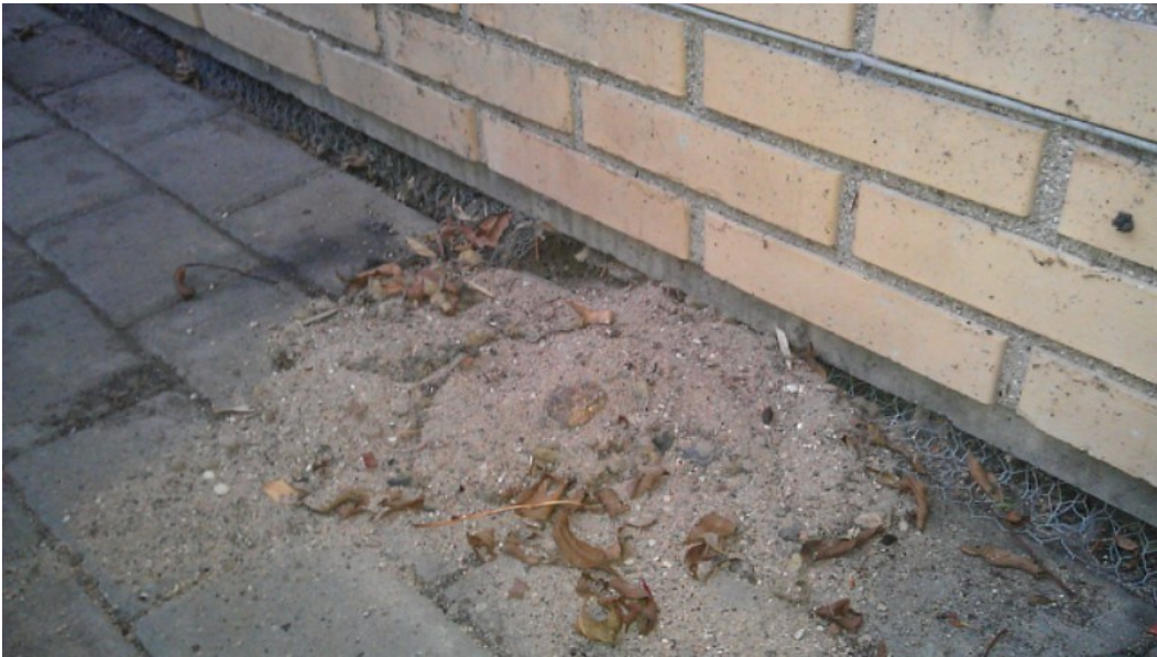
BILLEDE 39 ROTTEHUL MED JORDFANE – GRAVET OPPEFRA.
